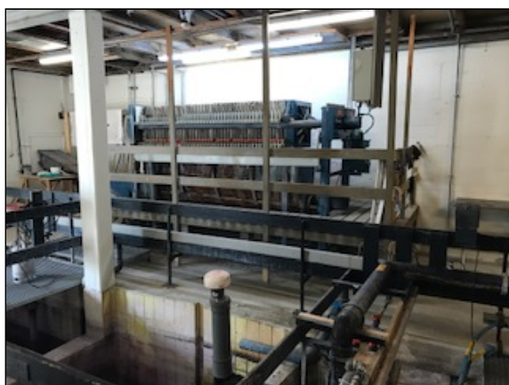
Spildevandsforrenseanlægget, tidligere slampresser
