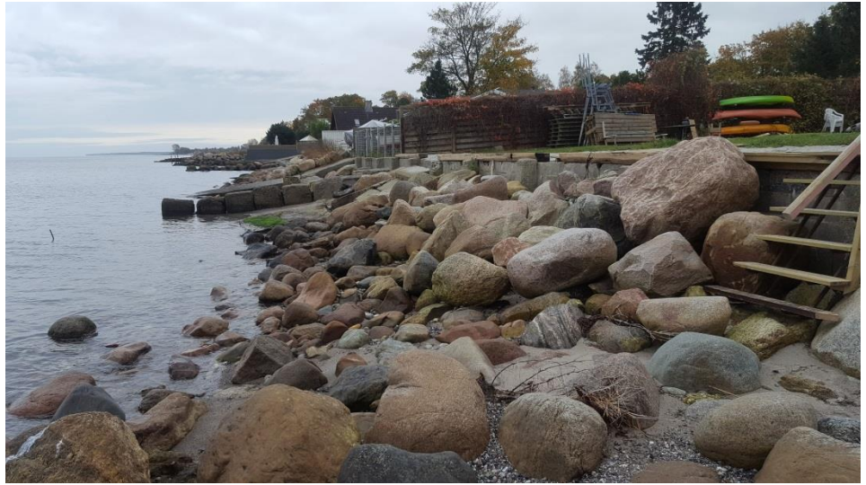
Figur 4.10: Stenkastning foran en kystmur, st. 1100.
