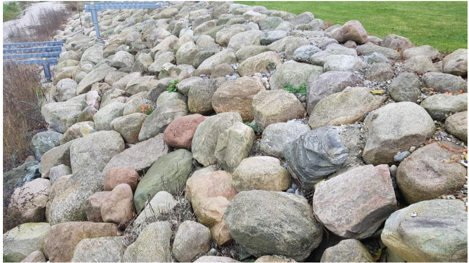
Figur 4.48: Skråningsbeskyttelse med god hældning og stabilt- liggende dæksten, st 6550.
