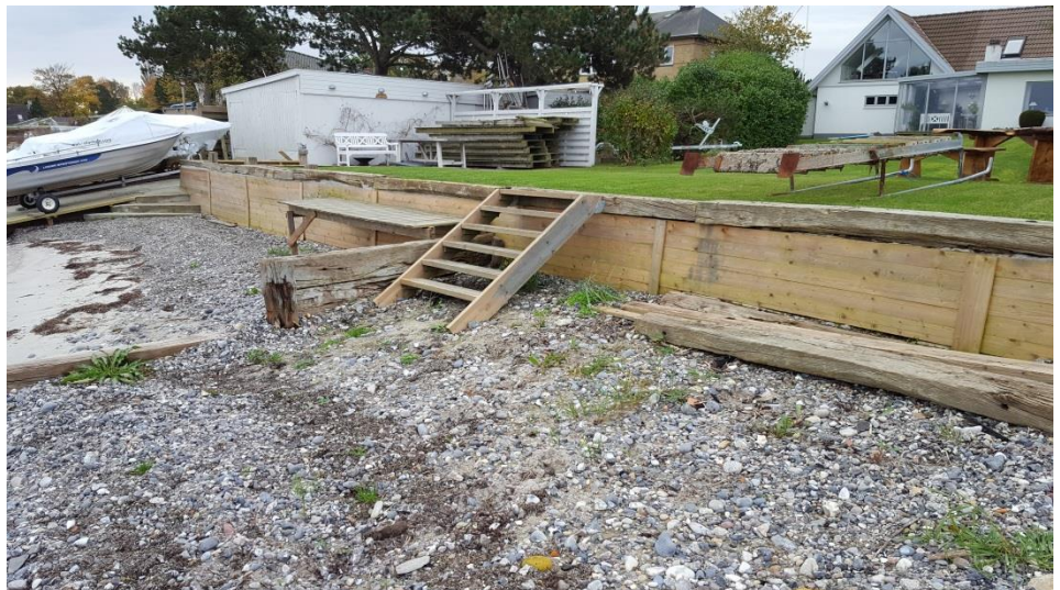
Figur 4.11: Eksempel på palisadevæg i træ og kystmur i beton, som ikke er i god stand.
