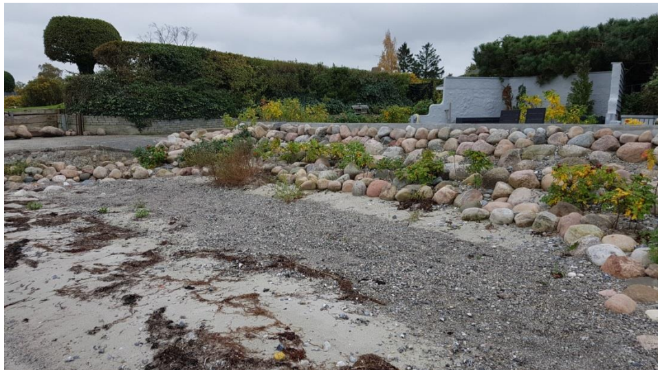
Figur 4.34: Højvandsmur med foranliggende skråningsbeskyttelse, som er korrekt opbygget, st. 3520.
