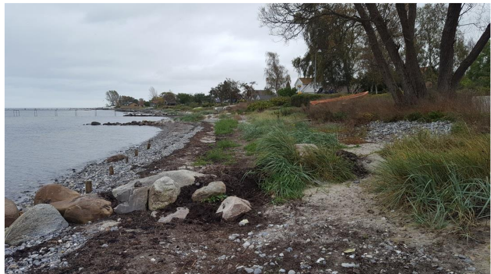
Figur 4.22: Langs kystlinjen ligger et rallag. Skråningen op mod Kystvejen har mange steder vegetation. Langs kysten ligger der høfder i dårlig stand.
