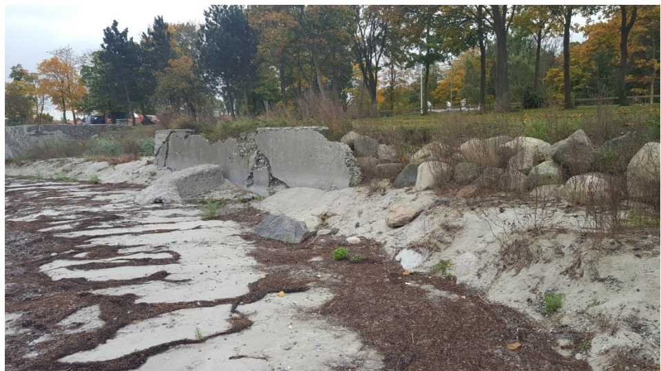
Figur 4.15: Kollapsede højvandsmur, erstattet halvt af stenblokke, st. 1350.
