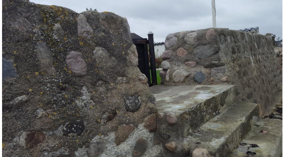
Figur 4.26: Ubeskyttet låge i højvandsmuren.
