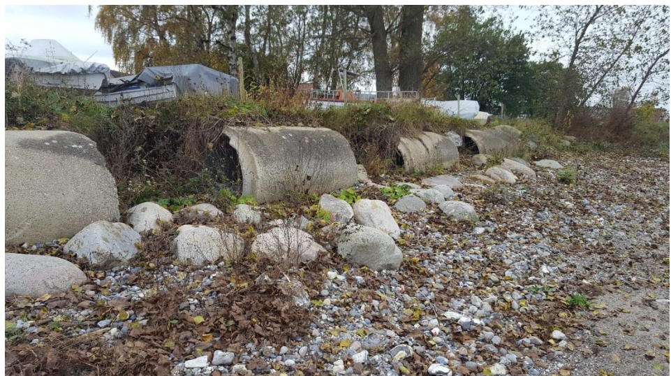
Figur 4.30: Betonrør er langt som skråningsbeskyttelse ved jøllehavnen, st. 2940.
