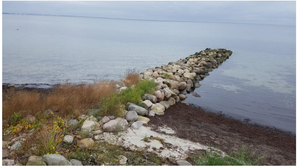
Figur 4.37: Korrekt opbygget hofde, som vil forsinke langsgående sedimenttransport, st 4560.
