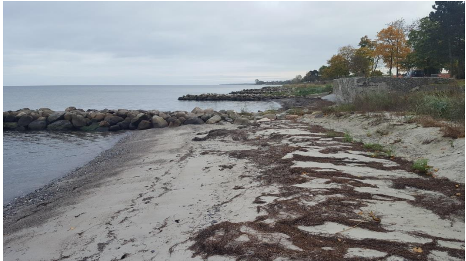
Figur 4.17: Eksempel på en hofde, der virker. Der ses en tydelig forskel i luv(nord) og læ (syd).
