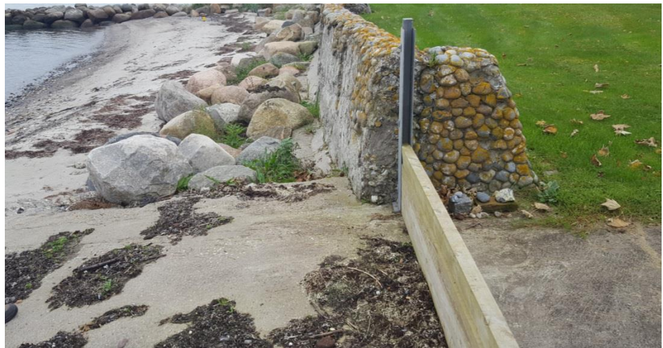
Figur 4.13: Eksempel på en højvandsskot i en åbning i højvandsmuren, st. 1290.
