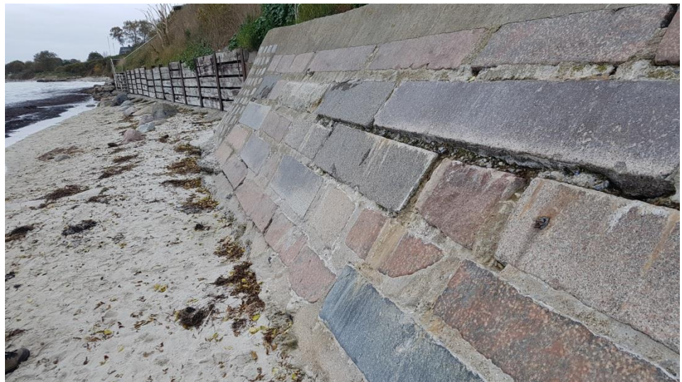
Figur 6.9: Kystmur og palisadevæg foran skråning ved st. 33.300.
