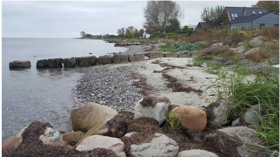
Figur 4.20: Høfderne på denne strækning er i dårlig stand, st. 2100.
