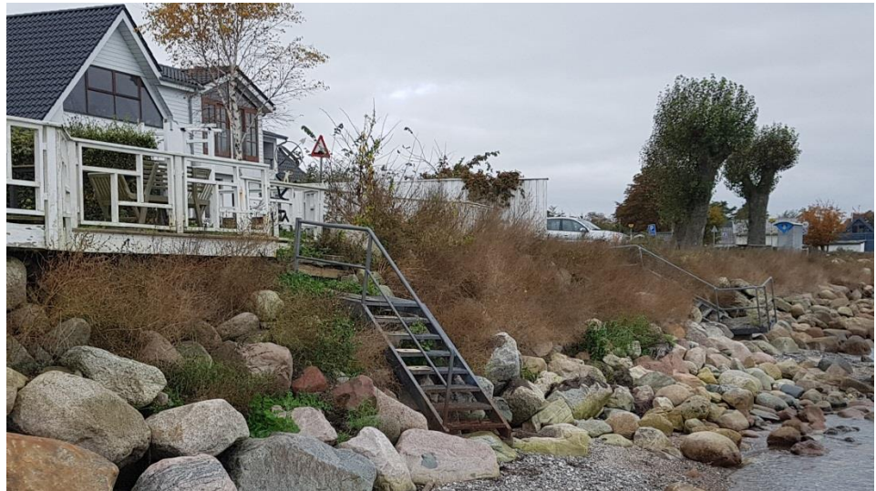
Figur 4.46: Mellem st. 5700-5750 er skrænten forsøgt beskyttet med stenkastninger.
