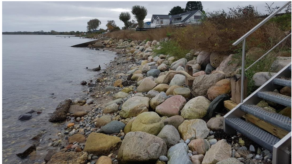
Figur 4.43: Kyststrækningen ud for stationeringslinje 6100. Skråningen er her beskyttet med skråningsbeskyttelse.
