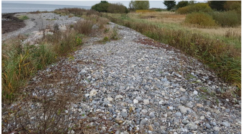
Figur 5.2: Bræmme af sten som virker som erosionsbeskyttelse.
