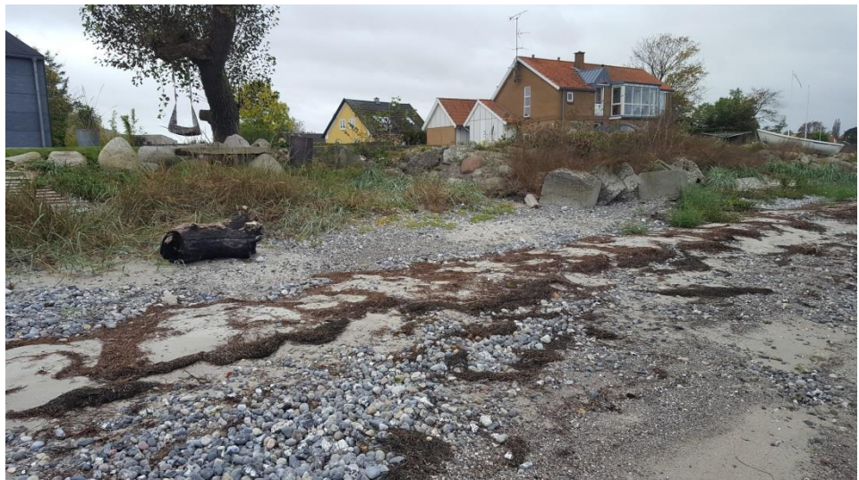
Figur 4.19: Skråningen har meget varierende beskyttelse både i kvalitet og materialer.
