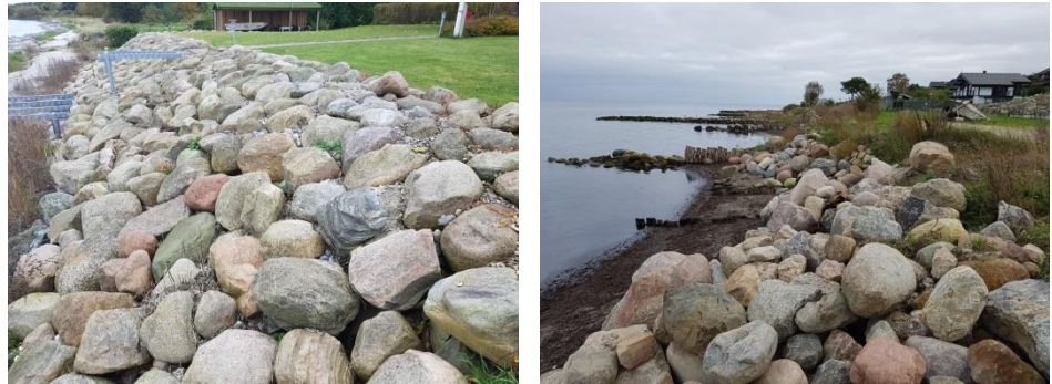
Figur 2.5: Sammenligning af skråningsbeskyttelse og stenkastning.
