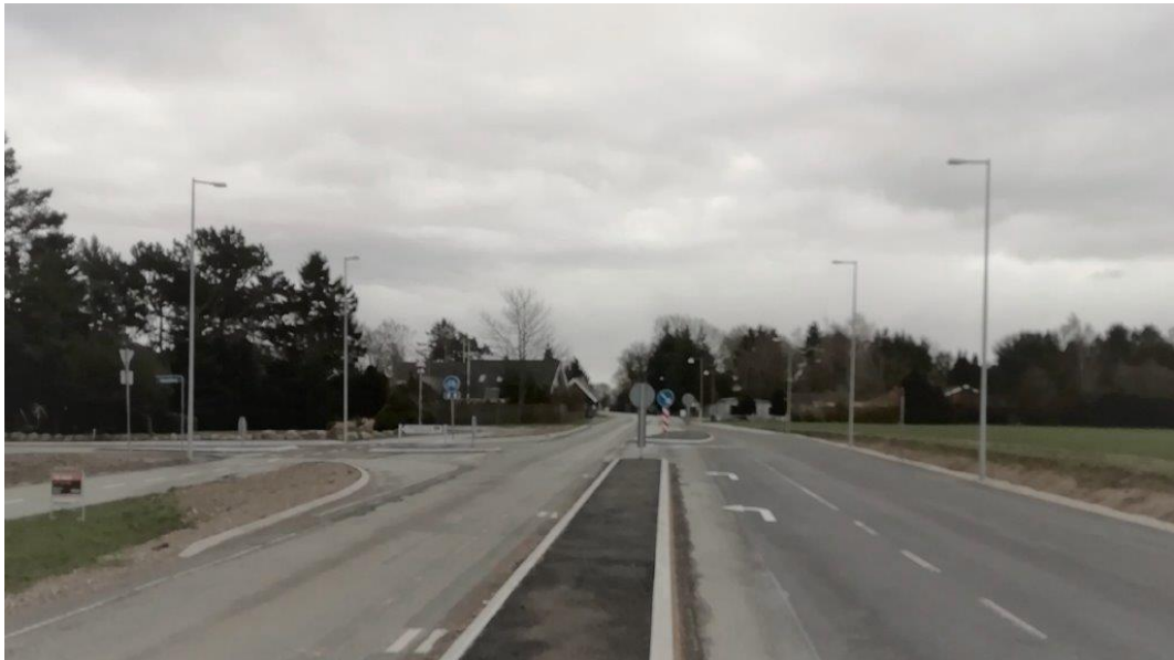
Billede 2: Krydset ved Stevnsvej og Valnøddevej efter ombygningen i 2018
