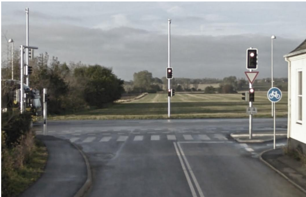
Billede 3: Signalanlægget ved Stevnsvej/Lendrumvej. Set fra Lendrumvej mod vest
