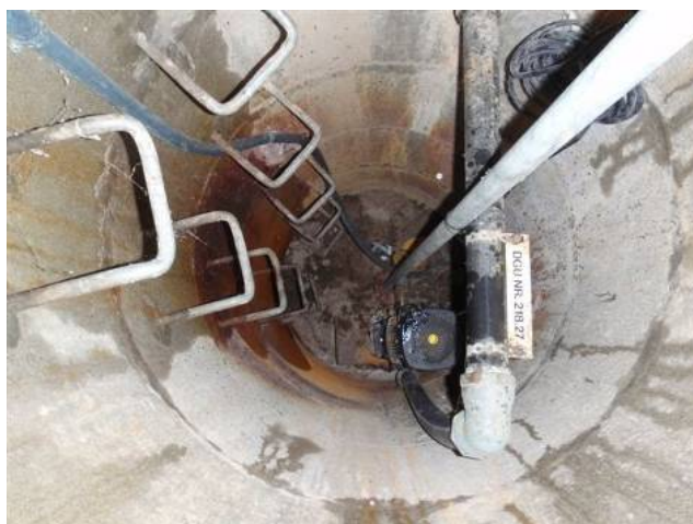
Figur 4.6 Boring hos Frøslev Vandværk
