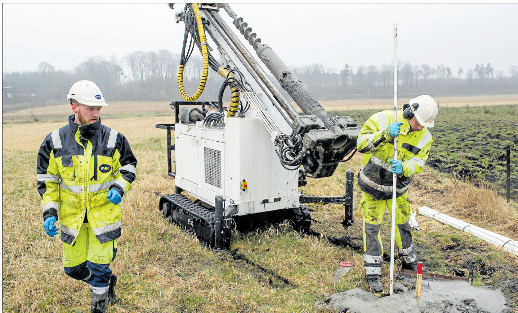
Et borehul. Det bedste er at finde et tykt lag gytje i jordlagene. For gytjen er god til at holde på vandet.
