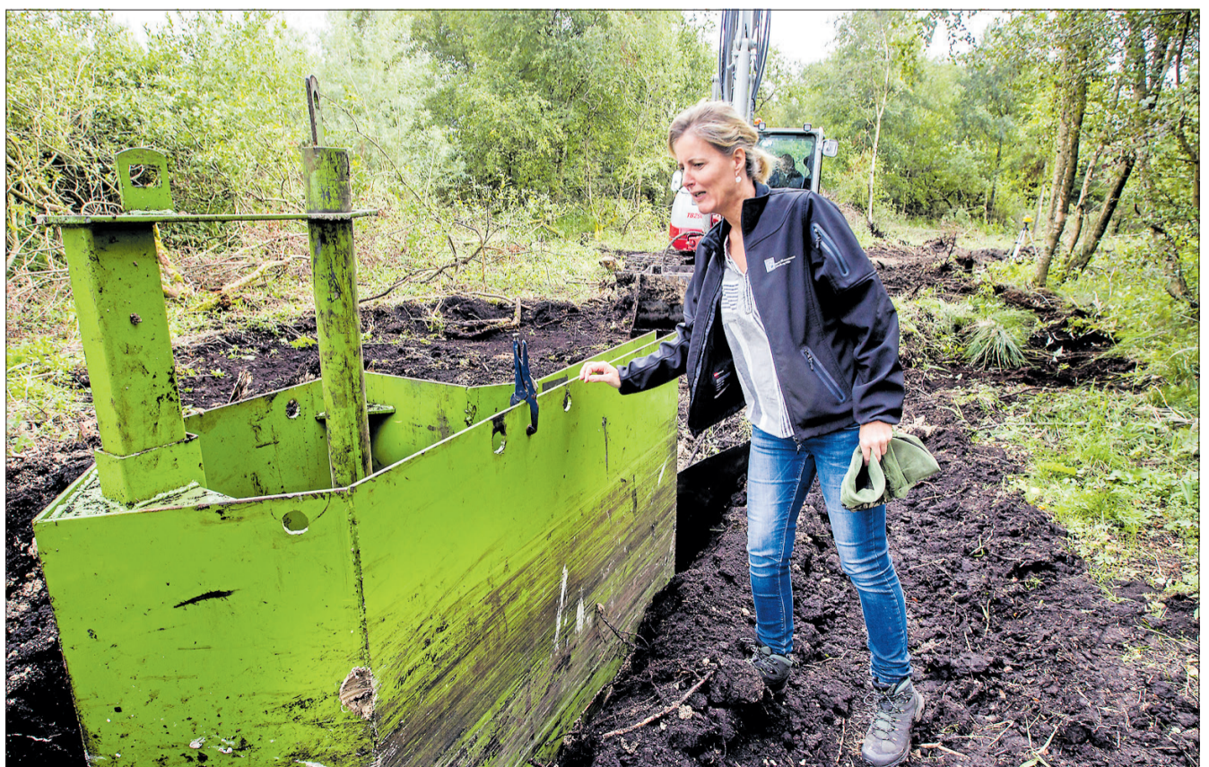
Projektleder Line Magnussen forklarer, at den grønne metalkasse trækker en sort plast-membran gennem renden, der skal omslutte højmoserområdet.
