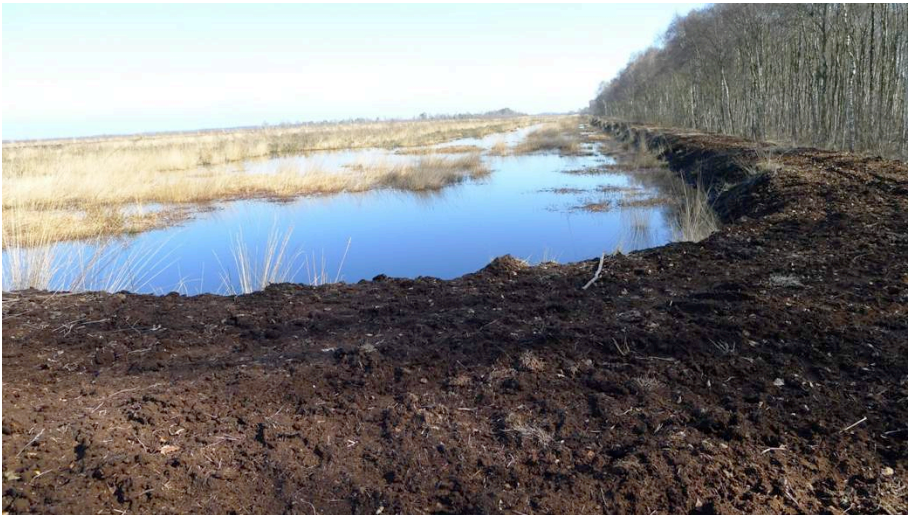
Fig 9.5. Forhøjning af eksisterende tørvedæmninger på Esterweger Dose, marts 2015. Forhøjningen skal minimere perioder med lav sommervandstand, og bekæmpe opvækst af birk.
