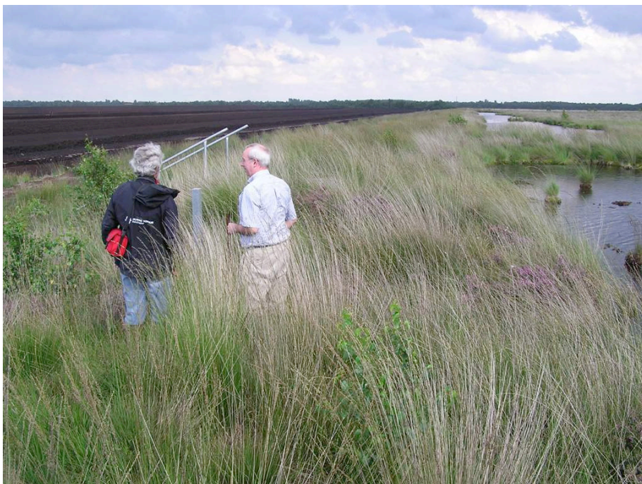
Fig. 9.2. I Schwanenburger Moor (2008) i Tyskland eksperimenteres der med genopretning af højmoser. I et i øvrigt gennemdrænet område er der opbygget tørvedæmninger på mange meters tykkelse og flere meter i højden. Det skabte bassin får udelukkende vand fra atmosfæriske kilder (regn mv.). Trappen illustrerer at man skal opad. Det er tørvens egenskaber til at tilbageholde vand der muliggør det.
