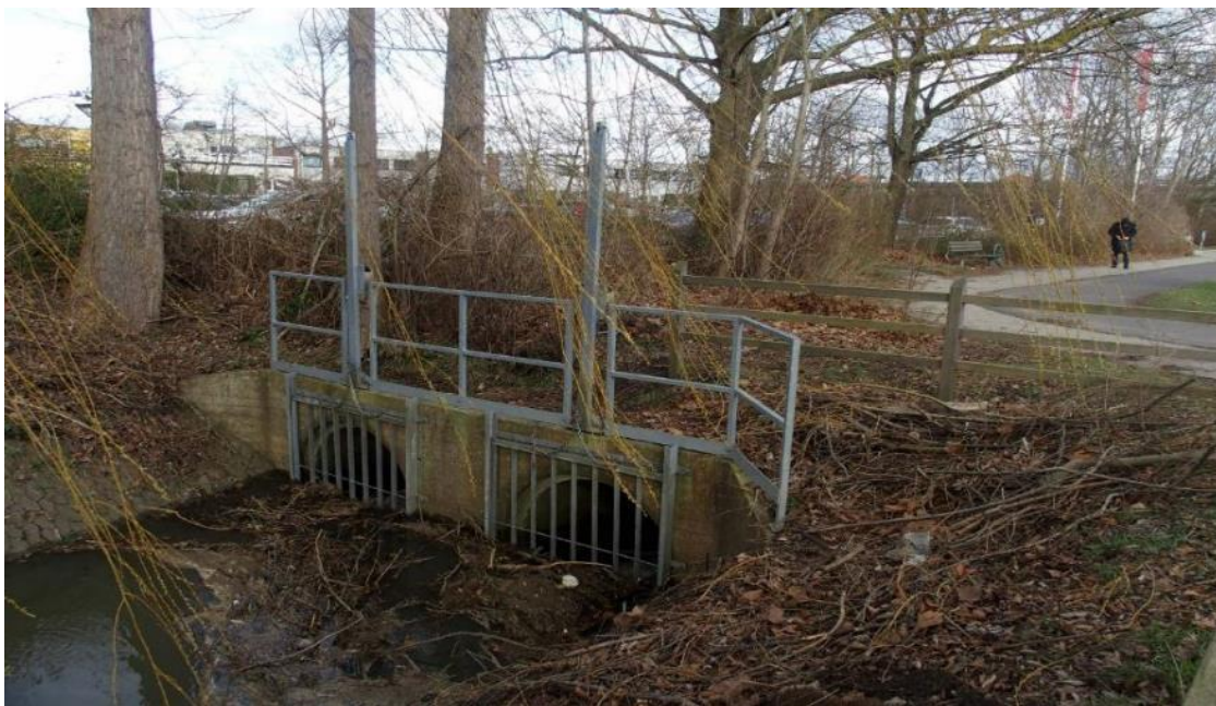
Figur 3-1 Solrød Bæks SF-stens beklædte forløb opstrøms den rørlagte strækning under Solrød Center. Denne strækning foreslås bevaret som om- eller nedklassificeret vandløb.
