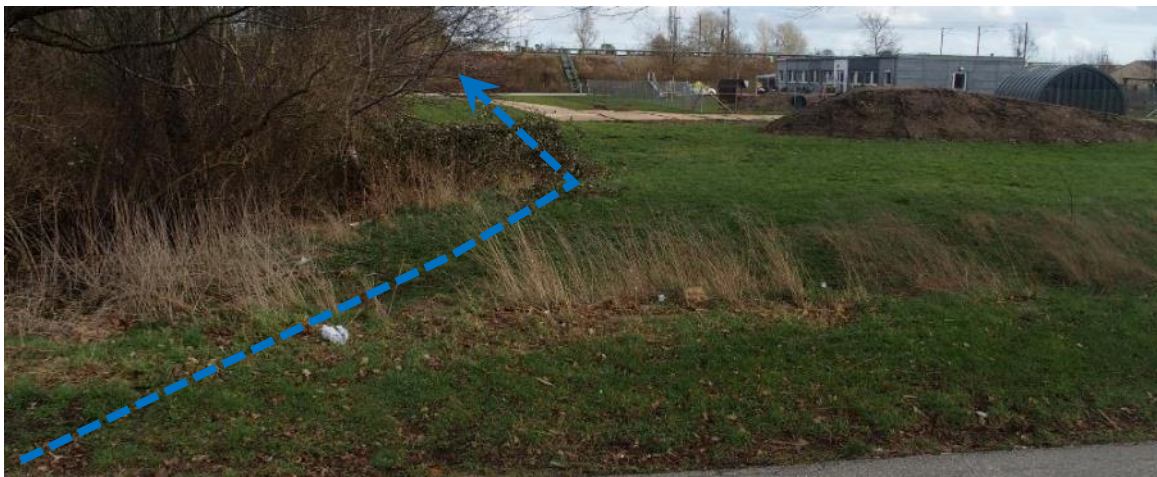
Figur 6-13 Strækning over "institutionsgrunden", hvor der er god plads, sideanlæg 1:3.
