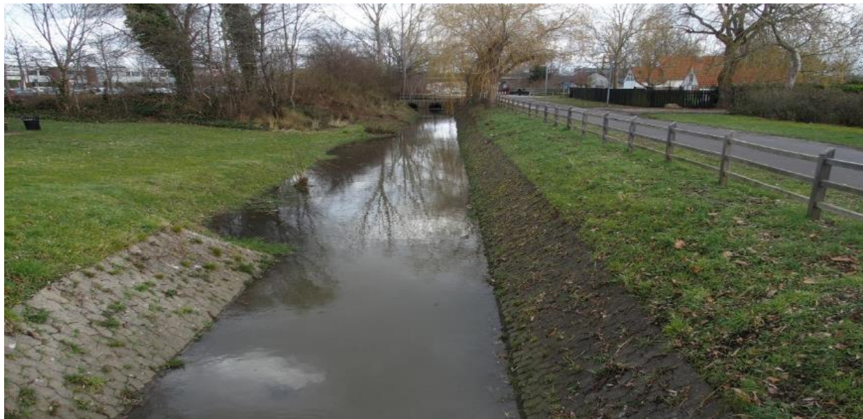
Figur 2-1 Solrød Bæk ved Mellemvang, set mod øst. Vandløbet er betonbefæstet og kanaliseret.
