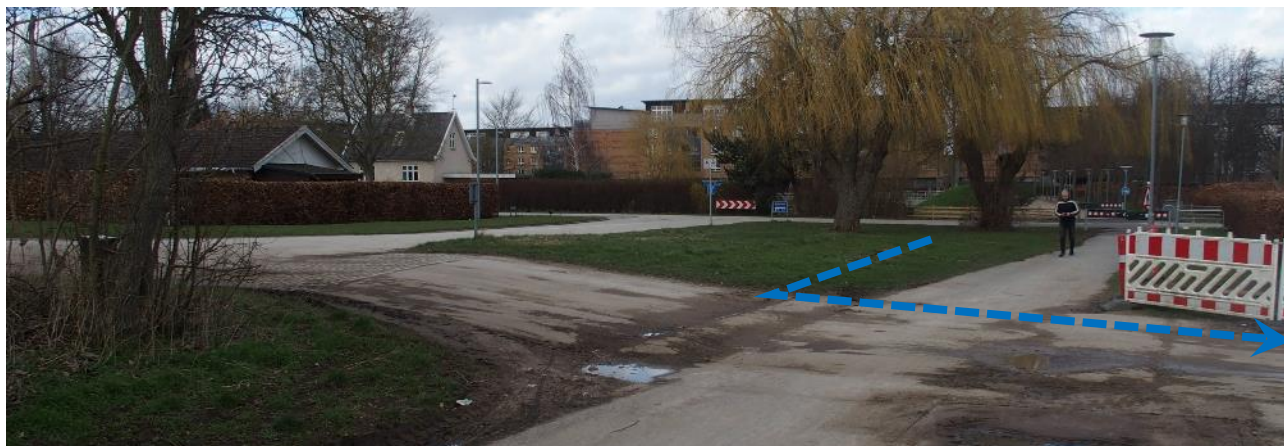
Figur 6-8 Vandløbet føres langs Littorinastien og krydser under denne ved indkørsel til Padelcenteret (under opførelse). Strækningen er pladsmæssigt udfordret - sideanlæg 1:2.
