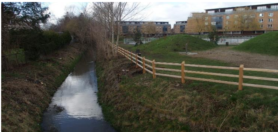
Figur 6-4 Vandløbet nær Mellemvang - vandløbets bund hæves og gives dobbeltprofil.
