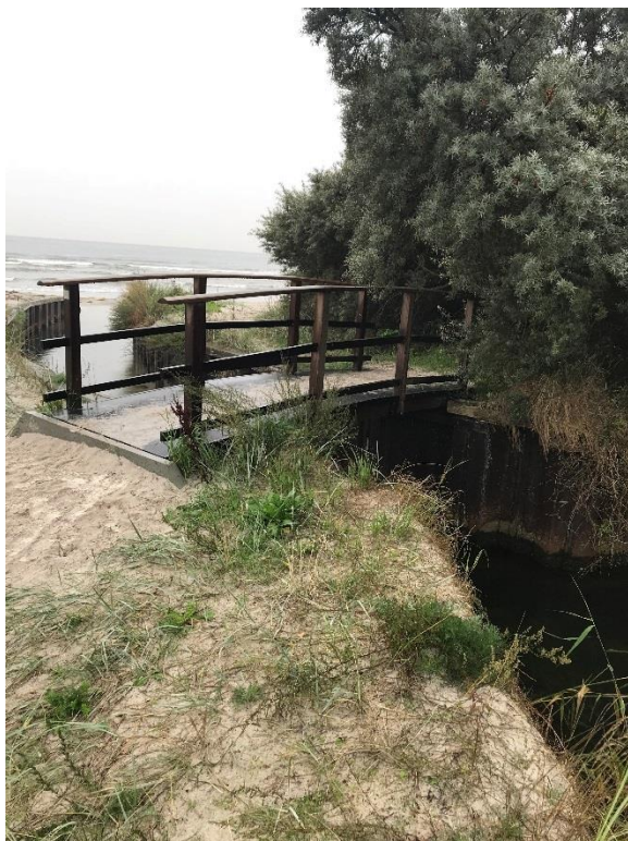
Figur 2-1: Gangbro over Karlstrup Mosebæk i stationering 1768 m. Broen er funderet på separate betonfundamenter bag spunsvæggen.
