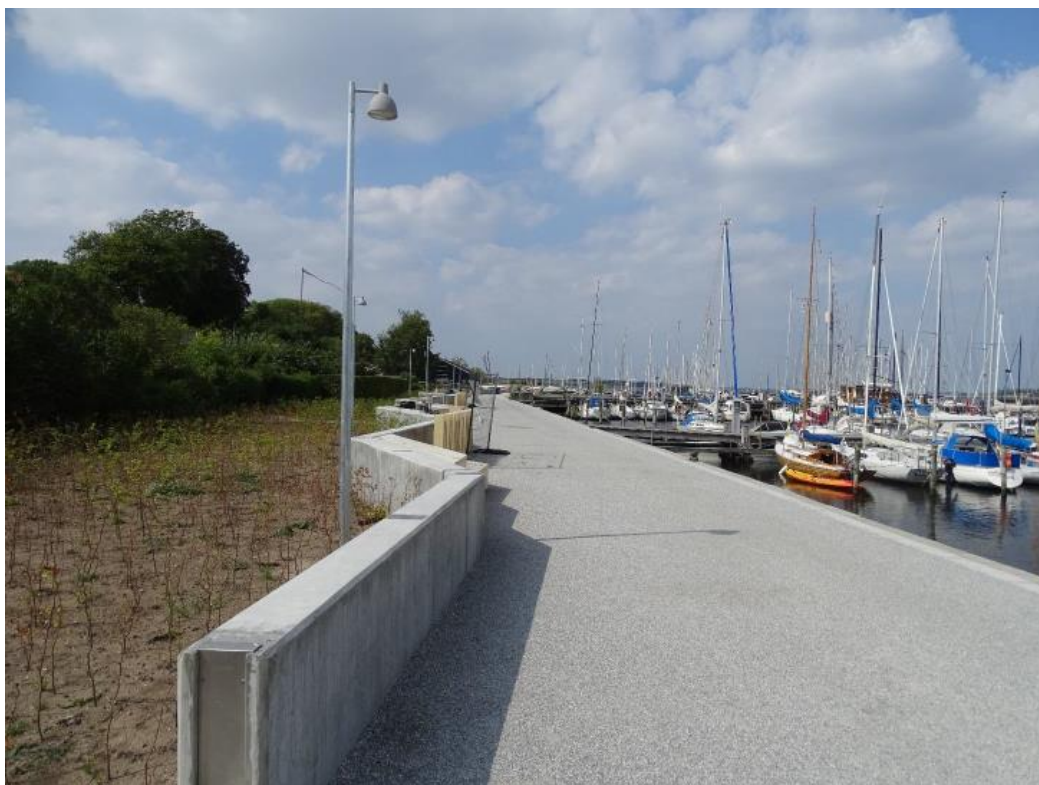
Figur 19: Højvandsmur i beton, eksempel fra Roskilde
