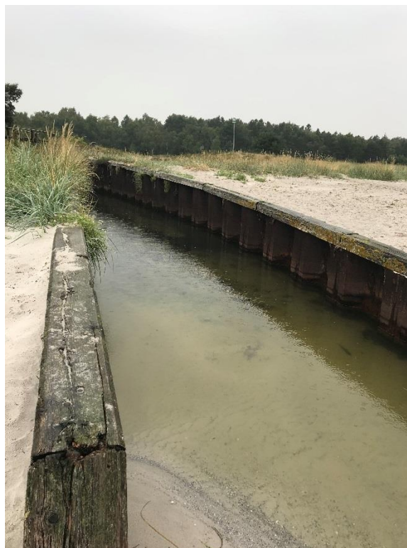
Figur 2-2: Spunstrug ved udløb af Karlstrup Mosebæk igennem strandarealet. Spunsen er afsluttet med træhammer.
