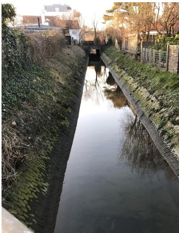
Figur 2-8: Bro og gennemløb under Solrød Strandvej set fra nedstrøms side (øst).
