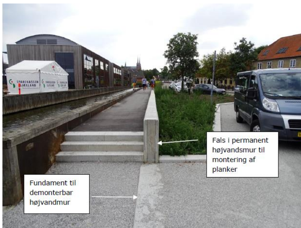
Figur 16: Eksempel på overgang mellem fast højvandsmur og demonterbar mur fra Roskilde Inderfjord
