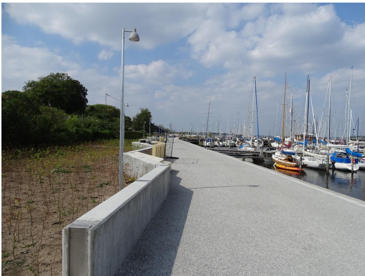
Figur 4-20: Højvandsmur i beton, eksempel fra Roskilde
