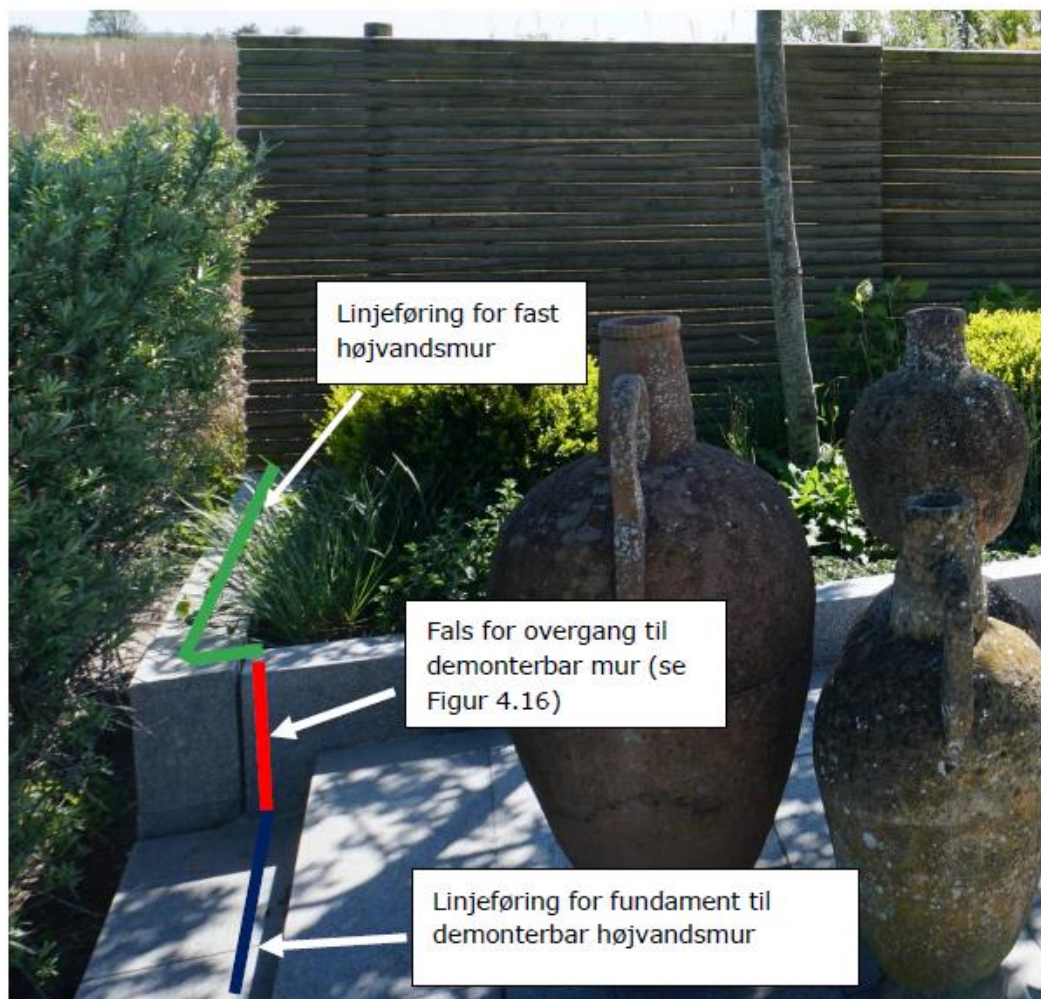
Figur 18: Foto fra Fuglesangsvej 20 (taget mod syd) med indikation af linjeføring ved overgangen mellem fast og demonterbar højvandsmur.
