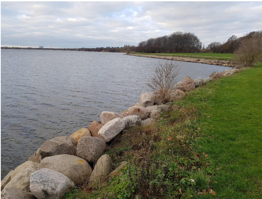
Figur 5: Eksempel på stenkastningsskråning fra Valbyparken. Der skal gøres opmærksom på, at størrelsen af de sten der er foreslået til Karlstrup Mosebæk, er væsentligt mindre end de viste sten.
