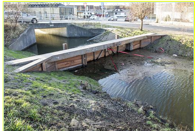
Figur 7: Eksempel på sluse Tv.: Sluse set forfra (opstrøms) med åbne porte. Th.: Sluse set bagfra (nedstrøms) med lukkede porte.
