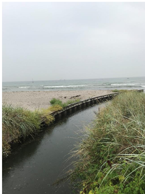
Figur 2-9: Solrød Bæk forløber i spunstrug på tværs af strandarealet til udløb i Køge Bugt.
