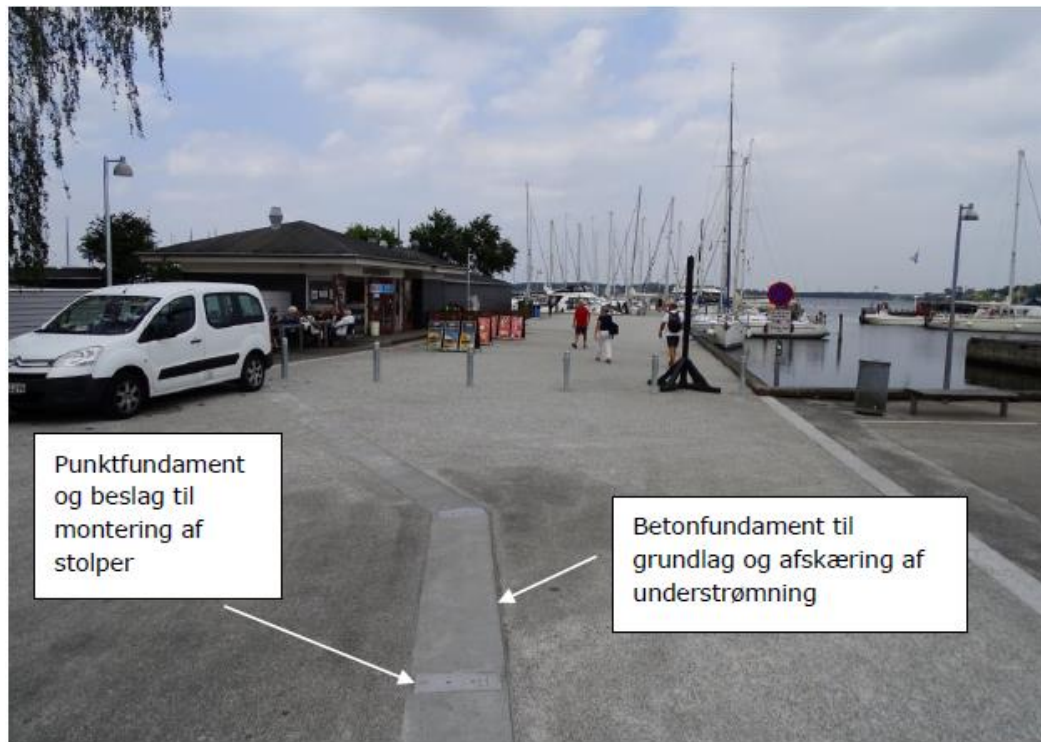
Figur 15: Eksempel på synlig del af fundament til demonterbar højvandsmur fra Roskilde Inderfjord
