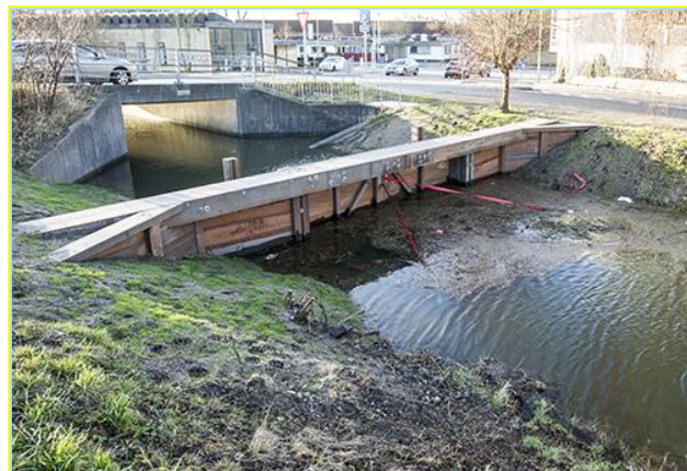
Figur 2-7: Eksempel på sluse Tv.: Sluse set forfra (opstrøms) med åbne porte. Th.: Sluse set bagfra (nedstrøms) med lukkede porte.
