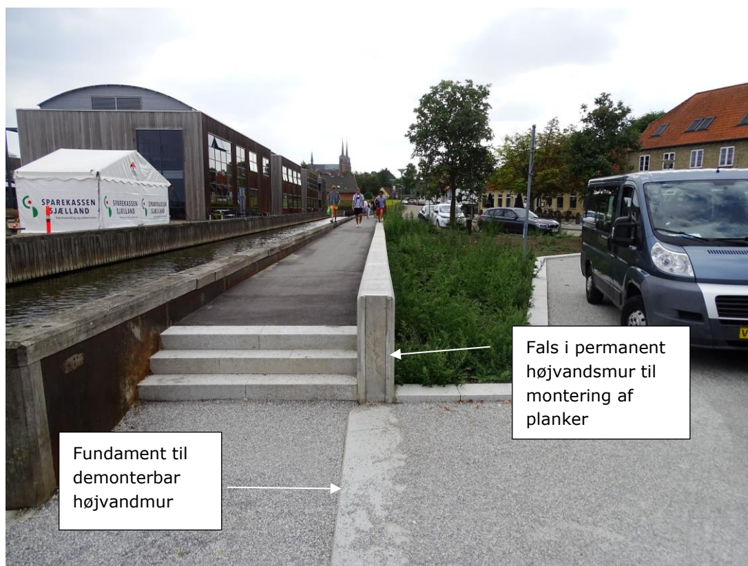
Figur 4-16: Eksempel på overgang mellem fast højvandsmur og demonterbar mur fra Roskilde Inderfjord
