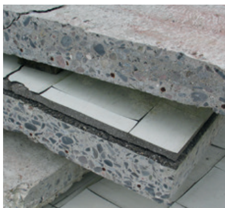
Betondæk fra industribygning. Gulvet er belagt med asfalt og vinylfliser. Indeholder tjærestoffer, asbest og blødgørere.
