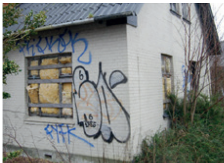
Kondemneret hus malet med blyholdig murlaling. Før nedrivning skal malingen renses af og opsamles for korrekt bortskaffelse.
