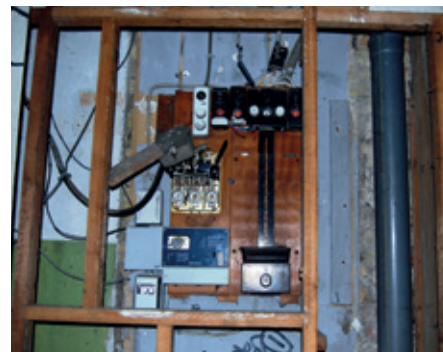
Eltavle kan indeholde relæer og andet elektrisk udstyr, der kan indeholde PCB og kviksløv.
