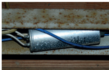
Ældre kondensatorer indeholder ofte PCB.
