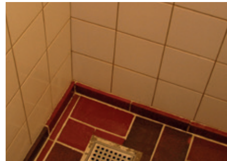
Asbestholdig fliseklæb. I ældre ejendomme er fliserne ofte sat op med asbestholdigt fliseklæb. Arbejdstilsynets regler skal følges ved asbestarbejde.
