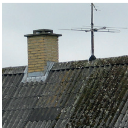
Ældre eternittage indeholder som oftest asbest.
