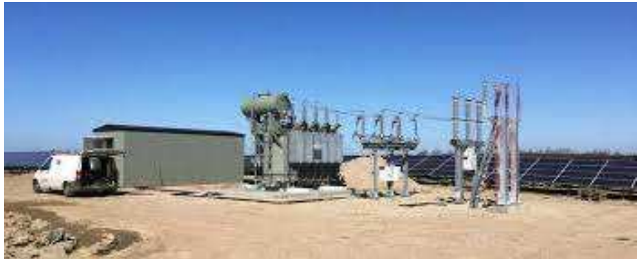
Figur 6 Eksempel på en step-up transformer
