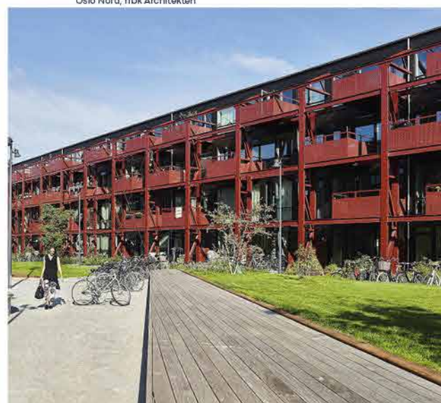
Valby Maskinfabrik: Montagehallen, C.F. Møller
