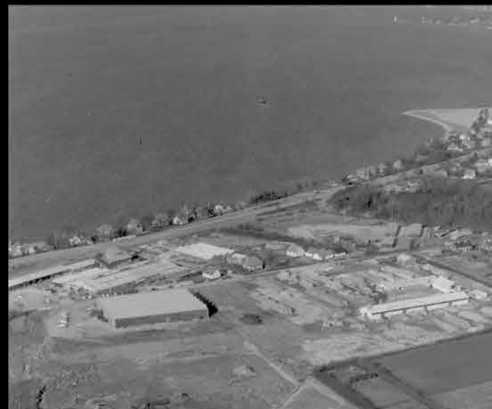
Udbygning af shedtagsbebyggelsen i 'baghaven' til villaerne langs Falstersvej. foto: Sylvest Jensen
