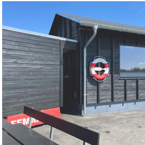
EKSIST. BYGNING SET FRA VANDSIDEN
