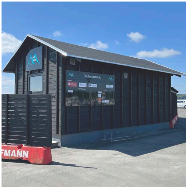
EKSIST. BYGNING SET FRA MOLEN
