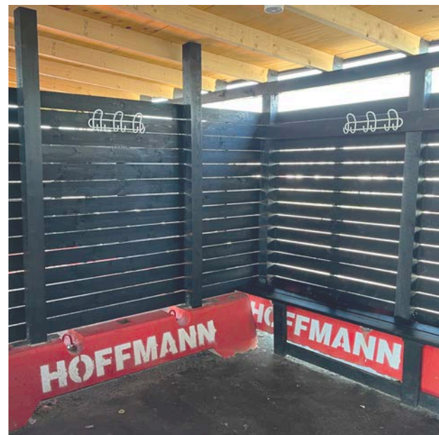
OVERDÆKKET UDENDØRS OMKLÆDNING
