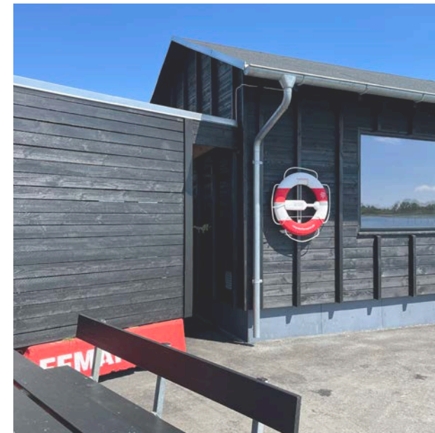
EKSIST. BYGNING SET FRA VANDSIDEN
