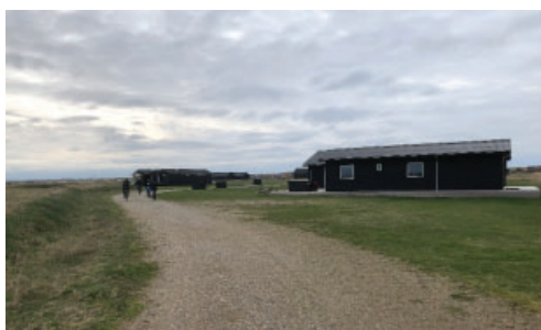
Veje skal etableres som grusveje.
