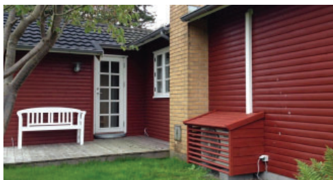
Eksempel inddækning af varmepumpe
