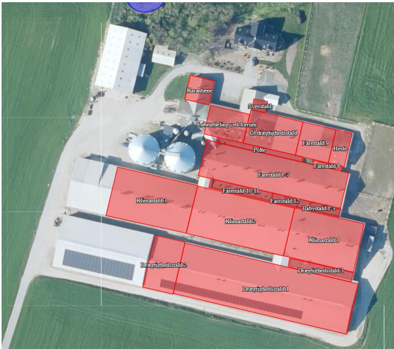
Figur 4. Staldanlægget, hvor det ses hvilke staldbygninger der er opført.
