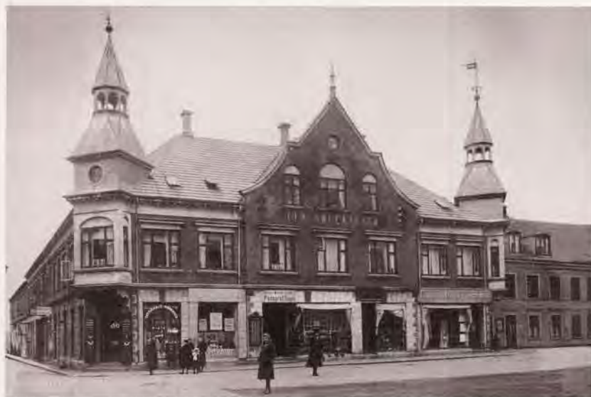
På Torvets nordside, byens vigtigste plads, står Centralgården fra 1905 med den markante frontkvist og hjørnetårnene som eksponent for fremgangen omkring århundredskiftet, hvor store statelige ejendomme afløste de ældre enetages byhuse. Foto fra o. 1905, udlånt af Lemvig Museum.
