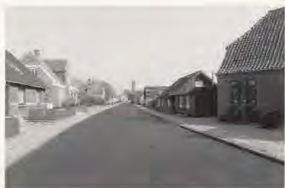
Den vestlige del af Bøgelundvej med villabebyggelse og den store dominerende kornsilo i sigtelinien.
