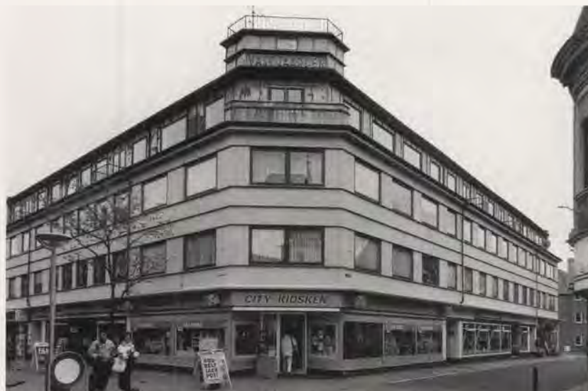
Vasegaarden, Vasen-Østergade, Lemvig, opført i 1935. Ark. Kresten P. Dalgaard. Bygningen er Lemvigs første byejeendom i funkisstil, udført med stål, kobber og glas, der brød med alle byggetraditioner. Den tårnlignende hjørneafslutning var bygningens markering ud mod Torvet – en funkisudgave af de ældre bygningers hjørnetårne og spir.
