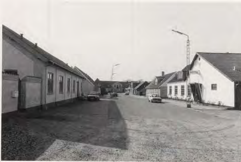
Den velformede stationsplads med omkringliggende facadebebyggelser er et særsyn blandt egnens stationsbyer. I ingen af de øvrige stationsbyer har området foran stationsbygningen fået en så markant pladskarakter som her i Ramme. Stationerne blev placeret ved en sidevej til landevejen. Og det var som regel landevejene, der trak byvæksten med sig, mens stationsområdets lidt afsides placering ikke virkede tiltrækkende på datidens bybyggere.
