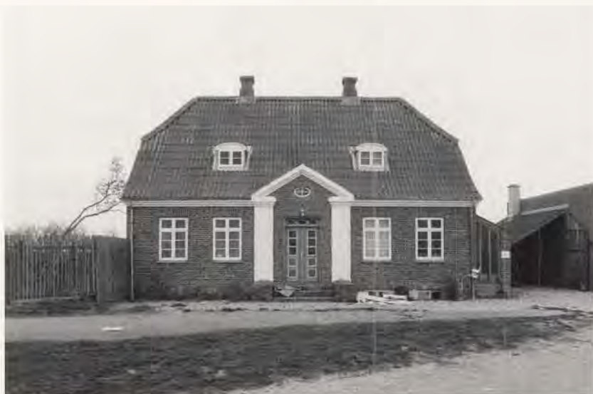
Kjeldbjergvej 13, Fjaltring, opført i 1921. Et Bedre Byggeskik-hus med fornemt indgangsparti og fine små tagkviste og skorstenspiber. Trods ny tagbeklædning med bølgeplader har huset bevaret sin helhedskarakter.
