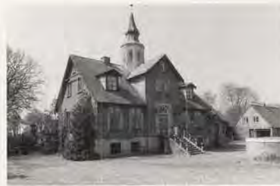
Holmgårdvej 49. Stuehus til Nørre Holmgård, opført i 1888. Eksempel på de villaprægede stuehuse, der undertiden afløste ældre længehuse. Huset er fremhævet af sin midterrisalit med frontkvist samt en tagrytter med svunget spir på skifertaget. Huset har tidligere haft kamtakkede gavle.
