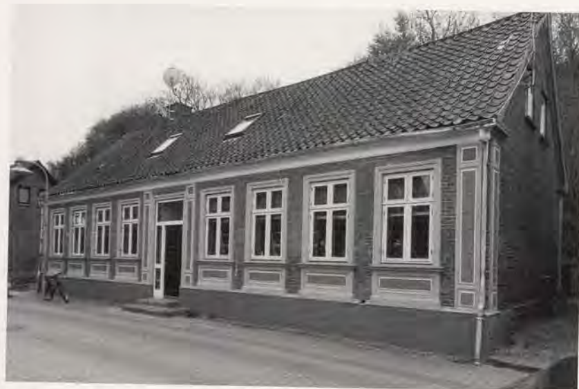
Frederiksgade 26, Lemvig, opf. 1885, er et karakteristisk eksempel på gadehusene med omfattende dekorationer. Hovedfacaden er præget af en høj gråkalket og glatpudset sokkel, rødt murværk, trukken hvidkalket hovedgesims, pudsede vinduesindfatninger og sælbænke samt blændingsfelter med rustikerede blændinger under vinduerne. Ved hushjørnerne og indgangsparti er udført lisenlignende dekorationer. En sand opvisning af dekorative elementer.
