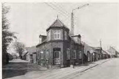
Tangsøgade 31, Bøvlingbjerg, opført i 1913. Lille gadehus med enkle facader og tårnagtig hjørnekvist, der giver huset en god arkitektonisk fremtoning ved vejkrødet.
