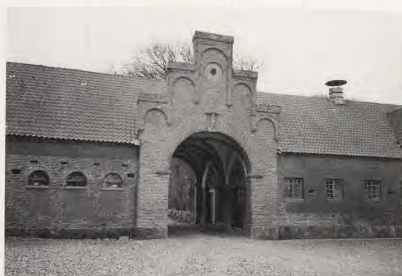
Kabbelvej 55, Nr. Lem. Kabbels portbygning i sydfløjen, opført i 1908. Portportalerne har historicistisk inspirerede kamtakkede gavle, dekoreret med romanske buer og hængestave. Det fornemme brolagte portrum er udformet med to murede ribbehvelv med ribber i røde teglsten og kalkede kapper, mens væggene er dekorerede med mønstermurværk. En værdig ankomst.
