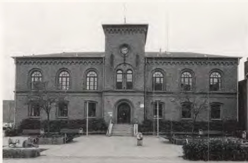
Østergade 10, Lemvig. Tidl. Ting-, Råd- og Arresthus, opført i 1877, ark. J. B. Løffler. Bygningens paladsagtige udformning er inspireret af den italienske renaissance. En fornem teglstensbygning præget af store murflader og enkelhed i dekorationerne. De høje etager og det tårnagtige midterparti giver bygningen et myndigt præg, helt i overensstemmelse med den oprindeligt planlagte anvendelse.
