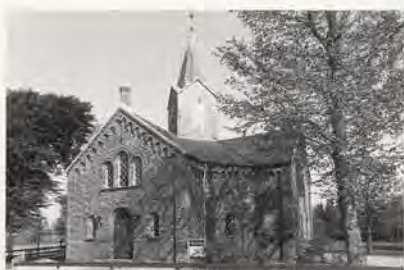
Johanneskirken, Kirkevej 6, Lemvig, opført i 1883 efter tegninger af ark. Andreas Bentzen for Lemvig og Omegns Valgmenighed. Korsformet teglstensbygning opført i romansk historicisme med rundbuede døre- og vinduesstik. Murfladerne er indrammet af hjørnelisener og en buefrise under taget.
