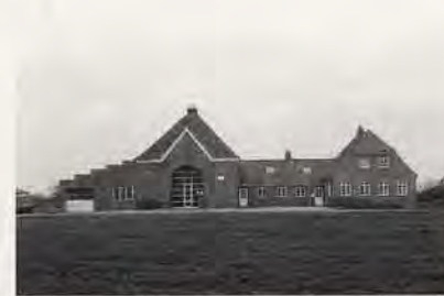
Vråvej 37, opført i 1932. Tidl. Fjaltring Elværk. Det fine bygningsanlæg er et velbevaret eksempel på de små elværker med høj generatorbygning og stort portparti, som tidligere fandtes på egnen. Huset er opført i gedigent murværk og viser slægtskab med mejeribygningernes arkitektur.
