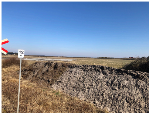
Udlægning af støjvold langs Lemvigbanen, der løber langs lokalplanområdets vestlige afgrænsning.
