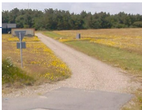
Veje skal etableres som grusveje.
