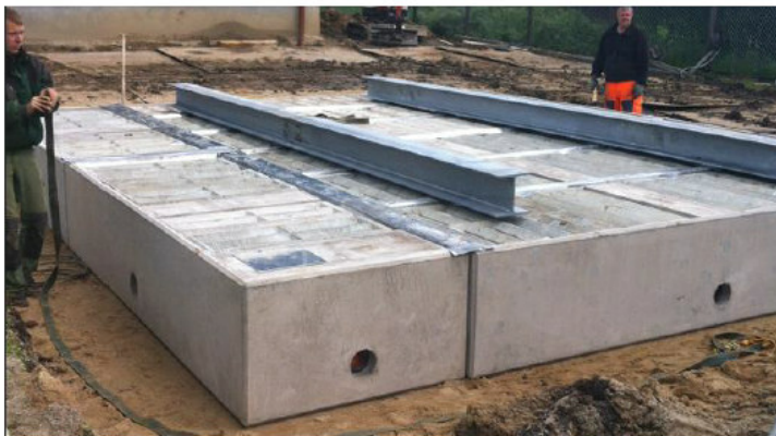
Eksempel på fundament opbygget af moduler hver med dimensionerne ( l \times b \times h ) = 3,6 m x 1,2 m x 0,8 m.
