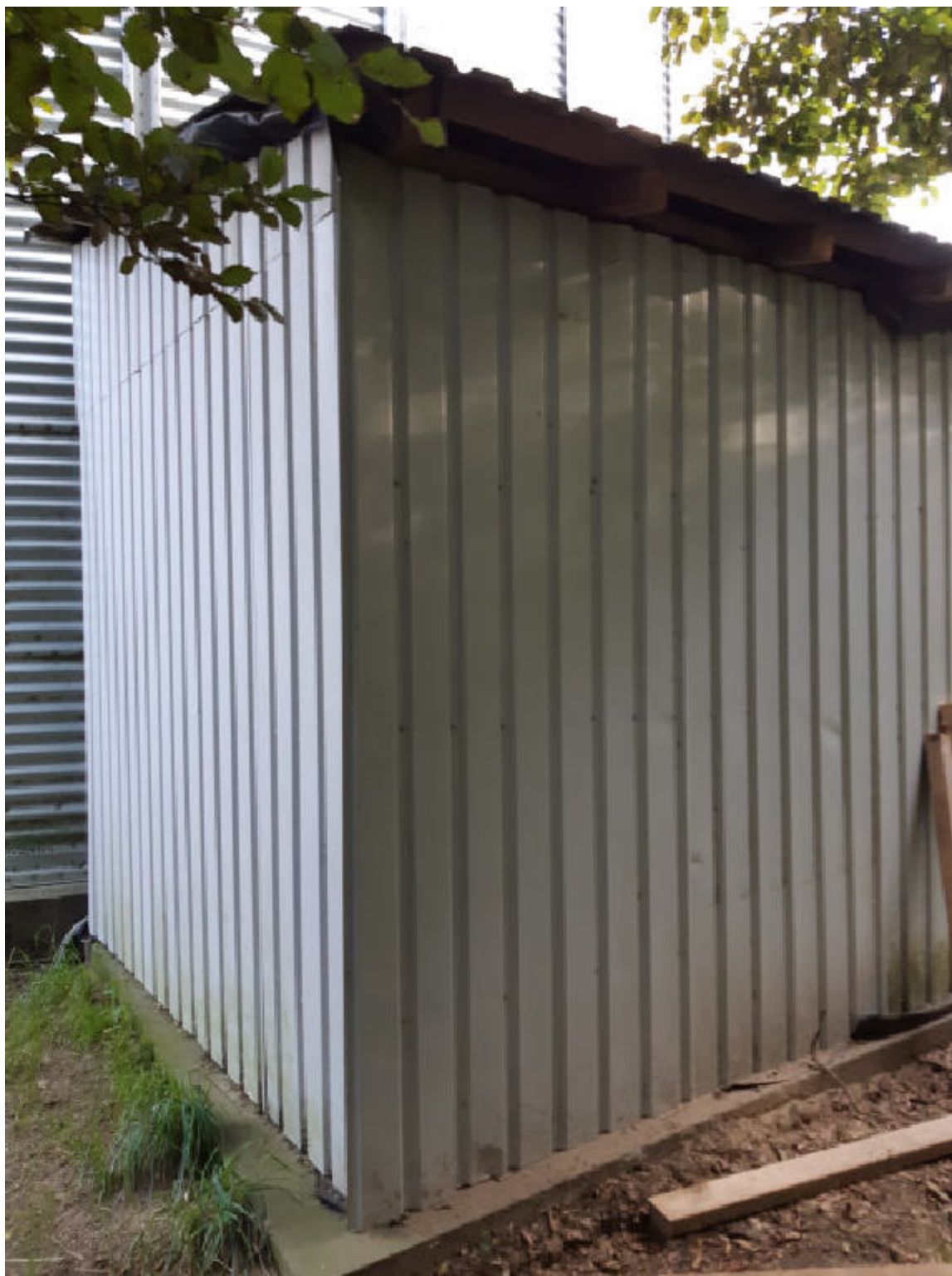
Foto syd for silo, fotoretning NNØ
