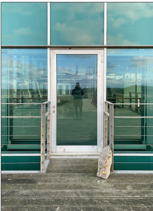
Foto af eksisterende materialer på kommende hovedbygning
