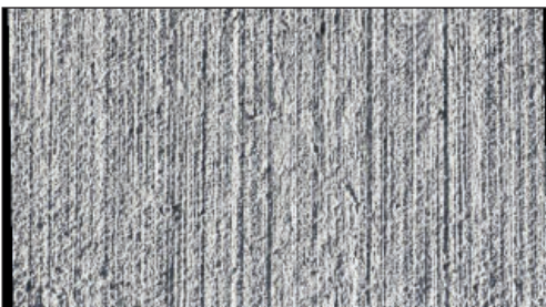
Eksempel på kostet beton
