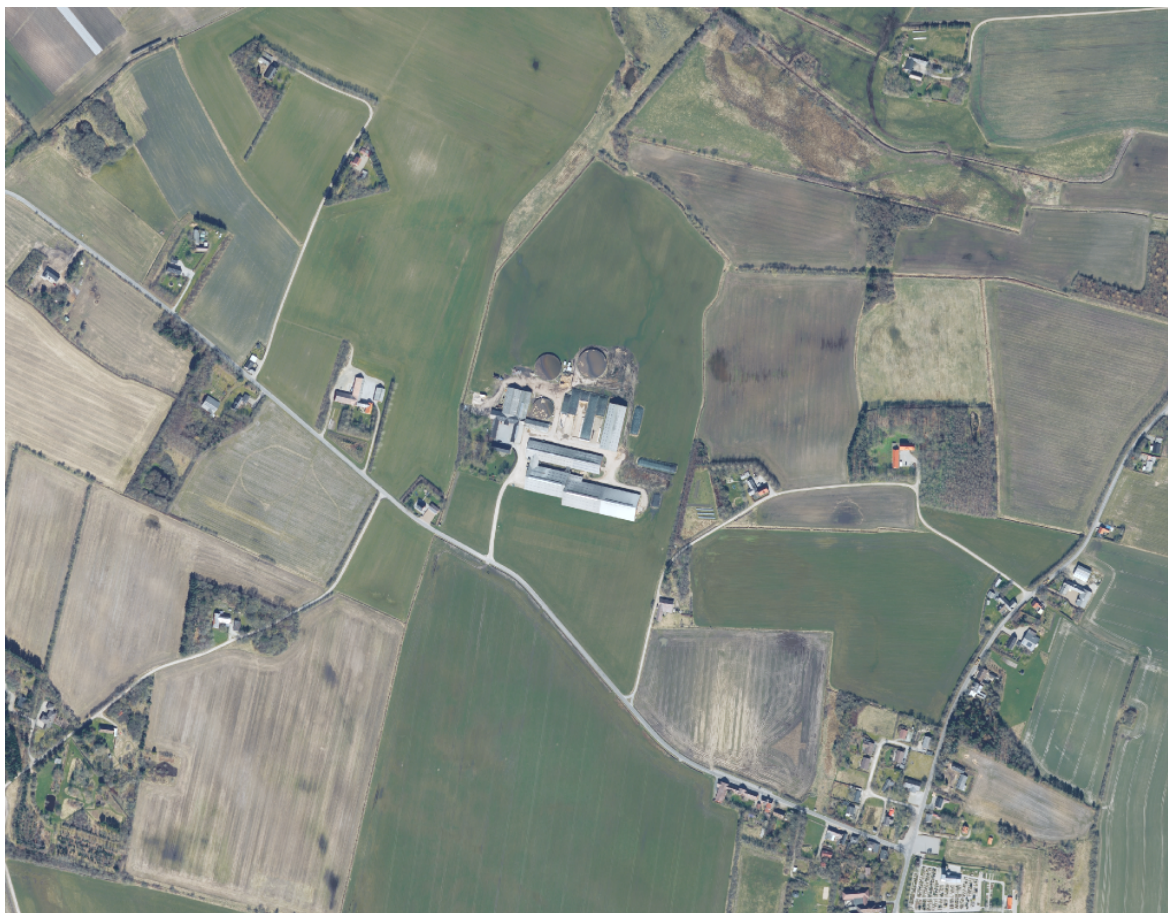
Luftfoto; Møborgkirkevej 53 i centrum af kortet, Møborg og Møborg kirke mod sydøst.
