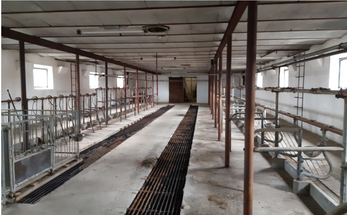
Gl. kostald. Bindestald med afløbsrist bag båsene. Hverken gulv- eller loftkonstruktion er brugbart i en nutidig svinestald.
