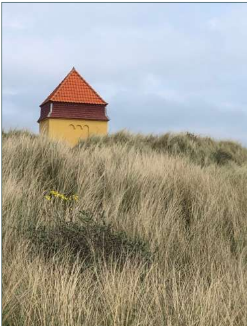
Det gule transformertårn ved Rav Aages Vej.
