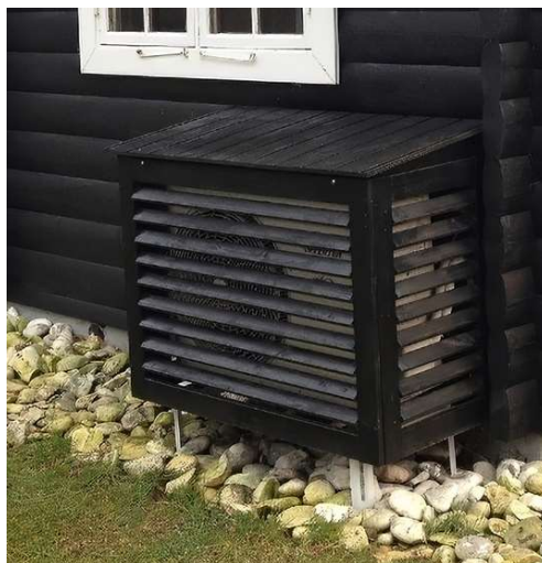
Eksempel på afskærmning af varmepumpe.
