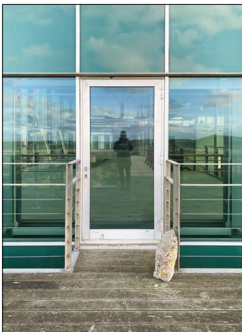
Foto af eksisterende materialer på kommende hovedbygning
