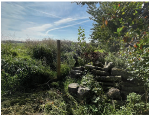
Eksisterende nedsivningsanlæg, godkendt til 15 PE.
