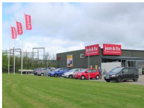
Eksisterende byggevarehandel på den østlige side af Ringkøbingvej.
