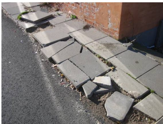
Billede 22 og 23: Knækkede fliser og inventar i gangbane i Jyderup.
