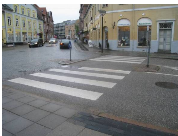
Billede 19 og 20: Billedet til venstre viser skilteskov ved kiosk på Smedelundsgade. Billedet til højre viser en reguleret overgang på Ahlgade. Her mangler opmærksomhedsfelt og blindekant ved helle.
