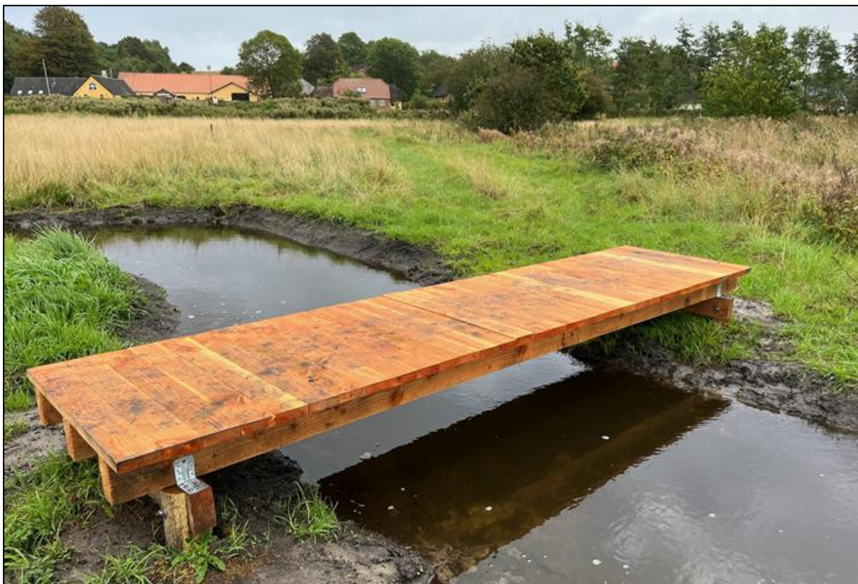
Figur 4-15 Eksempel på simpel træspang med cirka samme dimensioner, som projekteret i indeværende projekt.
