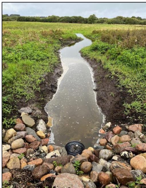
Figur 4-3 Eksempel på overrislingsgrøft med tilløb fra stort samle-dræn. Cirka 25 m nedstrøms løber vandet ud i engen, uden at der forekommer stuvning ved røret.
