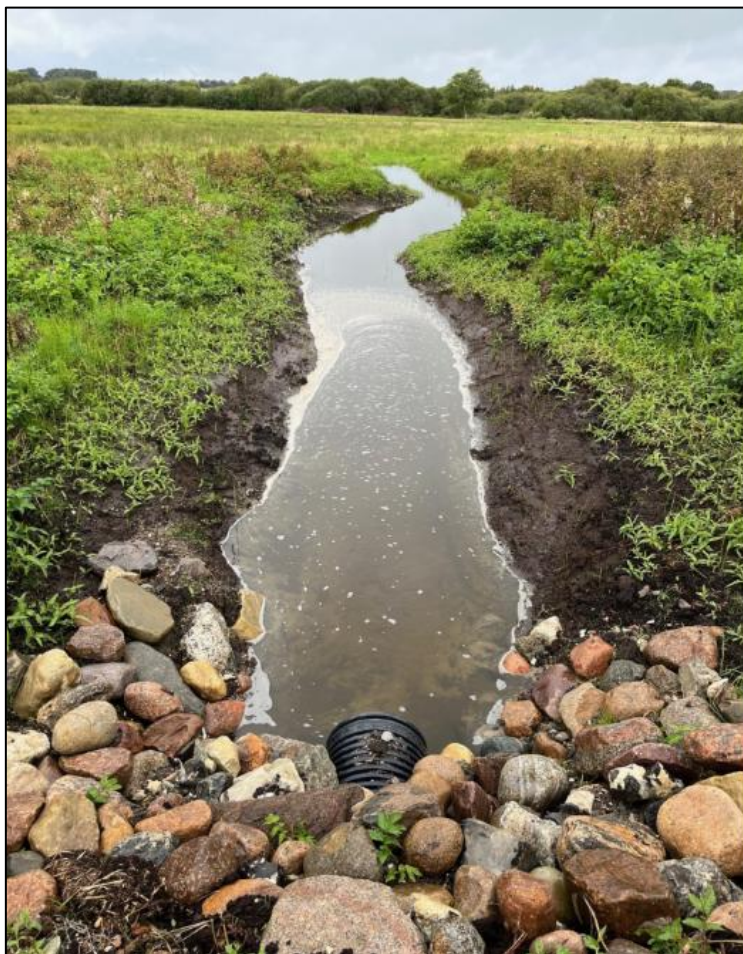
Figur 4-21 Eksempel på overrislingsgrøft med tilløb fra stort samledræn. Cirka 25 m nedstrøms løber vandet ud i engen, uden at der forekommer stuvning ved røret.
