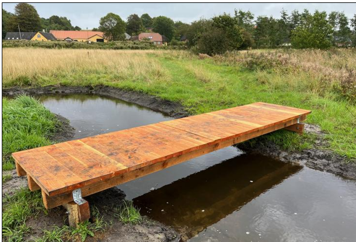
Figur 4-25 Eksempel på simpel træspang med cirka samme dimensioner, som projekteret i indeværende projekt.
