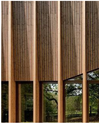
Træfacade med begrænset mængde glas
