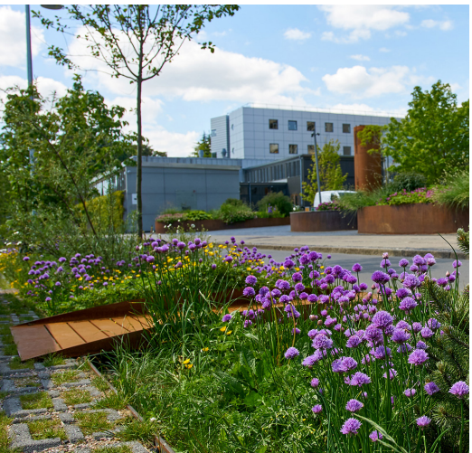
Reference fra Bülowvej, hvor der er overgange over regnbede
