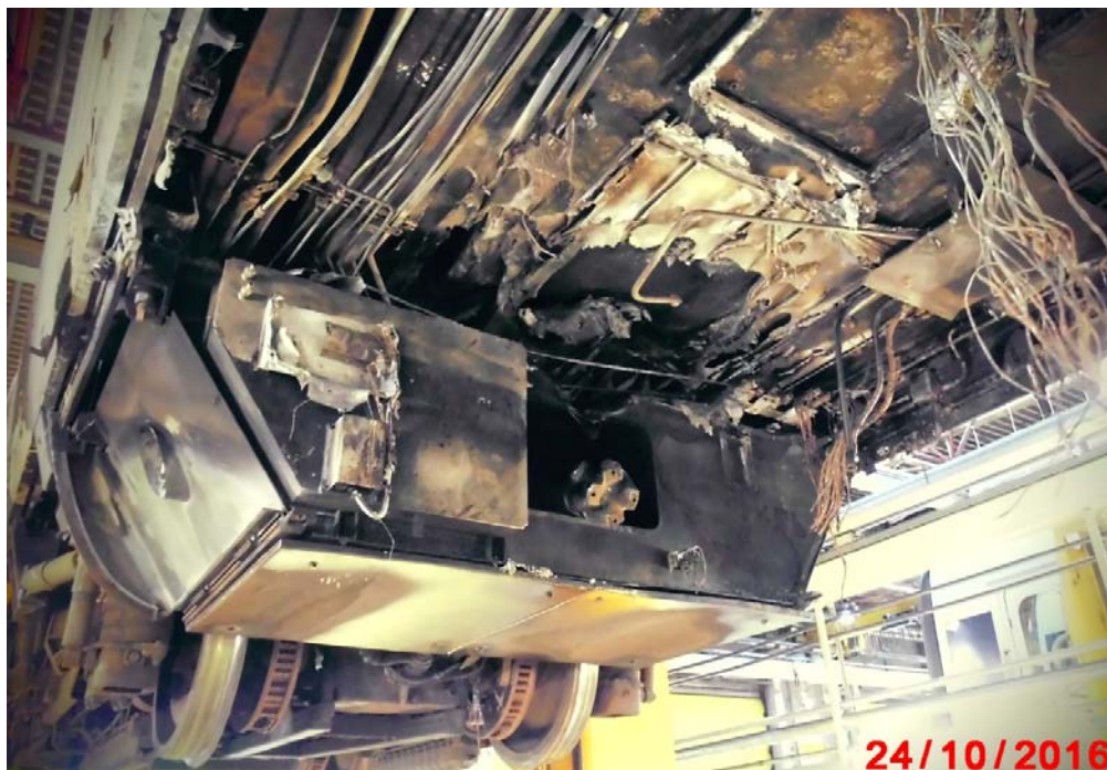
Billede 5. Skader på adskillelsen mellem undervogn og passagerafdeling ved motor / gear
