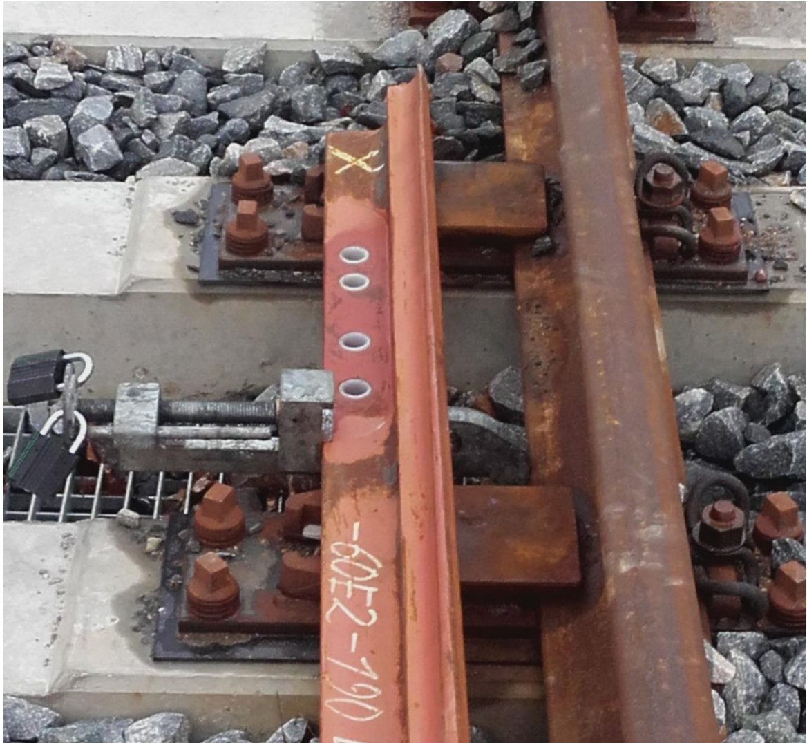
Foto 4 Fraliggende tunge aflåst med låsebolt type 1981. 03.03.2017 (Lokaltog)
