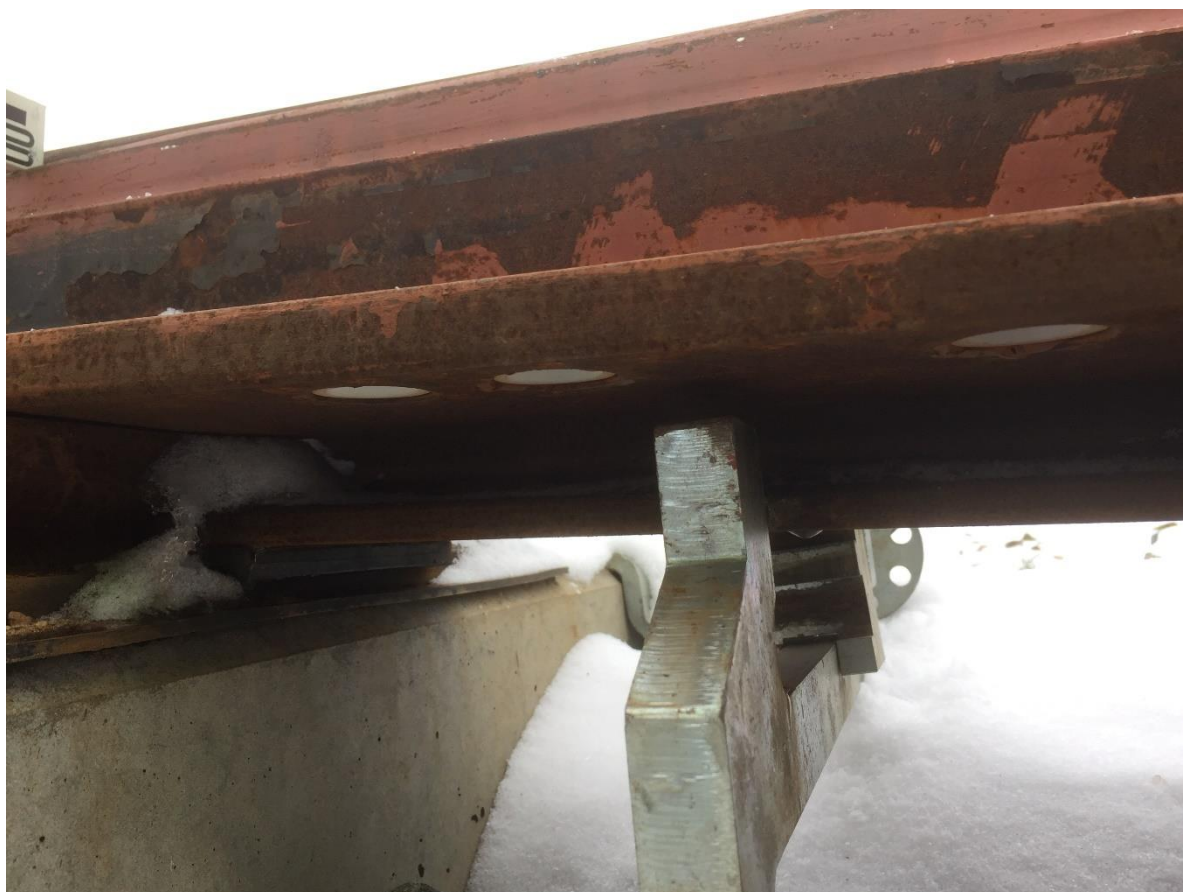
Foto 2 Den forkert monterede låsebolt. Låsearmens top sider under tungen.
