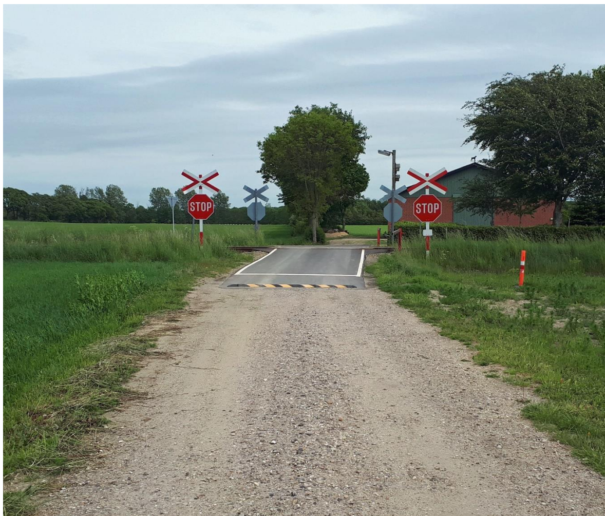
Foto 4 Overkørsel 161 set fra vest (Vardevej) 03.06.2019 (foto: politi)
