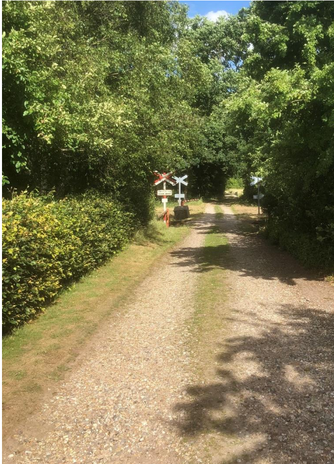
Foto 3 Overkørsel 163 set fra Vardevej
