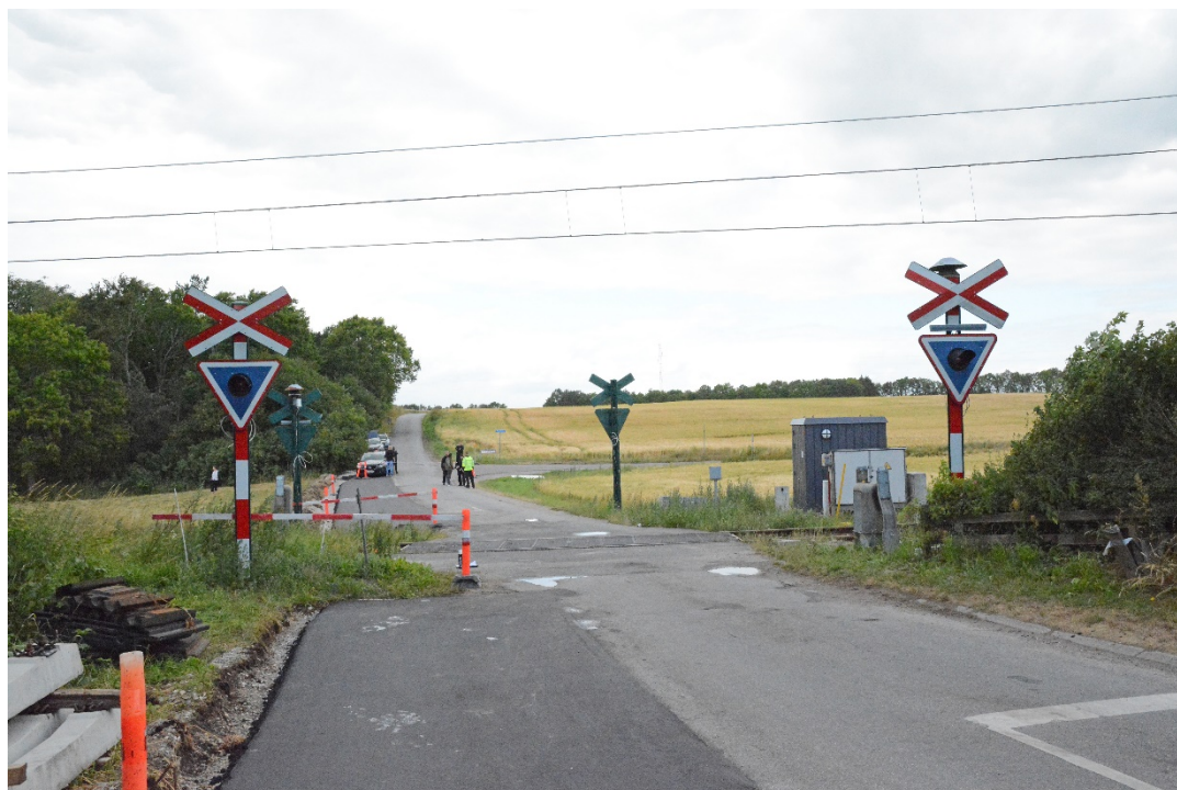
Overkørsel 102 set fra syd efter ulykken. Bemærk afspærringerne i venstre side, henlagt materiel i venstre side og bomdrev uden bom (men med lodretstående "arme") i højre side
