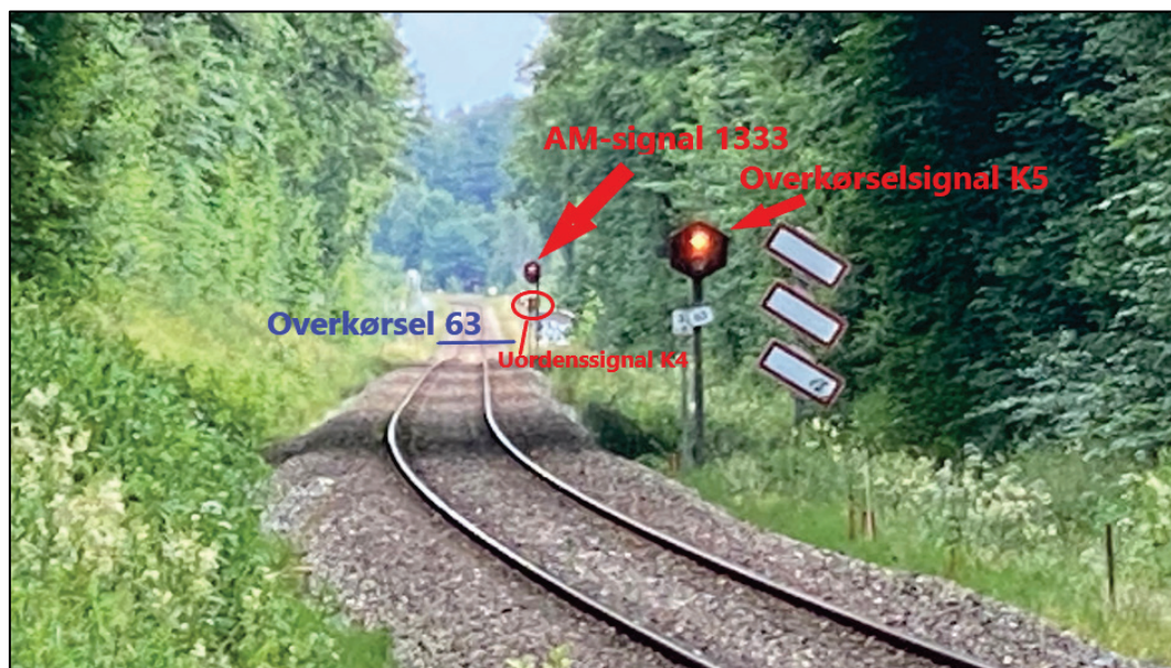
Figur 12. Foto taget i togets køreretning med markering af overkørselssignal K5 placeret 700 meter før overkørsel 63, AM-signal 1333, uordenssignal K4 og overkørsel 63.
