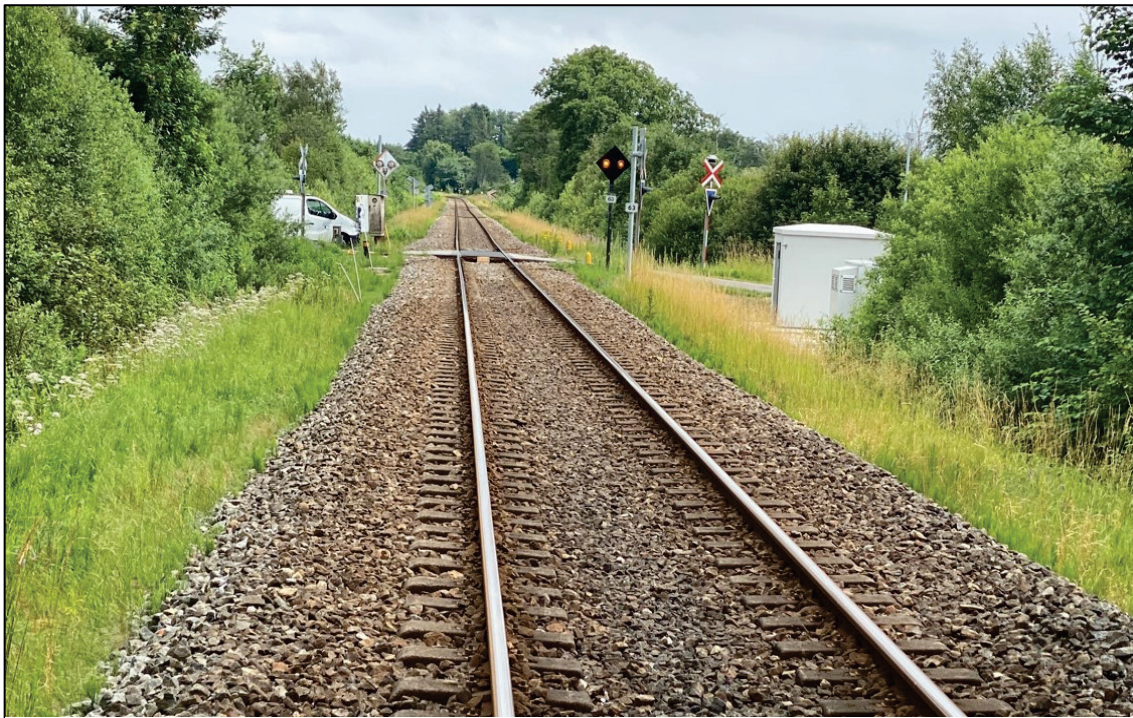
Foto 3. Togets køreretning ca. 50 meter før overkørslen.
