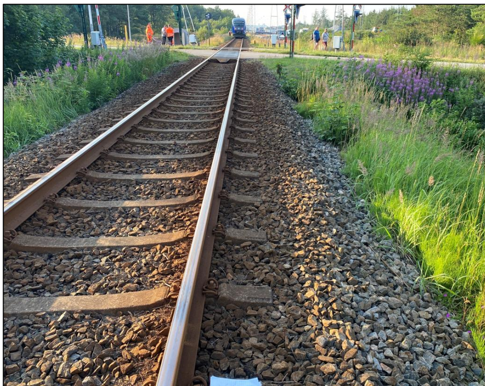
Foto 5. Mærker på skinnerne efter brug af magnetskinnebremse ses begynde her.
