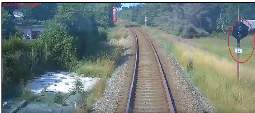
Figur 5. Optagelse fra togets frontkamera ved passage af overkørselssignalet, der er placeret til højre for sporet. Signalet er slukket. I rød ring længere fremme ses en af overkørselens bomme, som er oppe.
