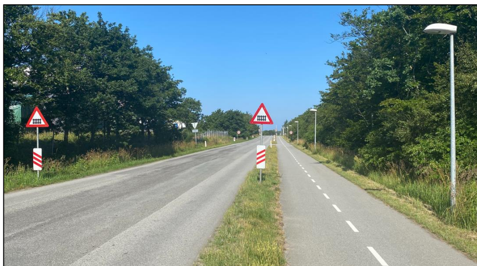
Foto 2, Søndergade set i vestlig retning ca. 250 meter før overkørsel. Færdselstavler A 73 med tilhørende A 75 undertavle opstillet i venstre rabat samt i højre rabat mellem vej og cykelsti.
