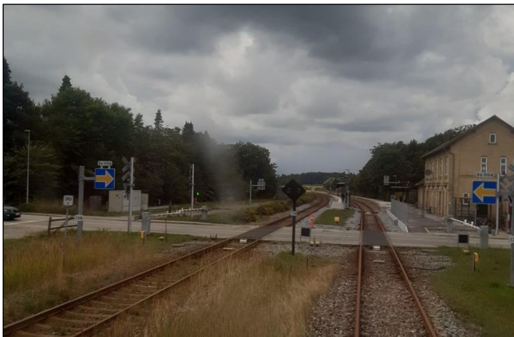
Foto 9. Eksempel på et ikke ugyldiggjort (og ikke fjernet) uordensignal på Sindal station efter indførelse af ETCS. Foto taget af lokomotivfører fra NJ d. 10-8-2021.
