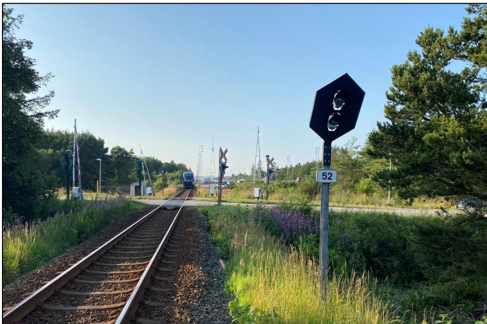
Foto 4. Slukket overkørselssignal A.01.2 ved overkørsel 52.
