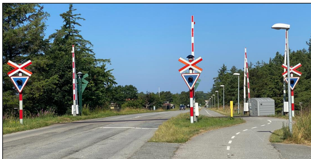
Foto 3. Overkørsel 52 stoplinje, vejsignaler og bomanlæg set i vestlig retning.
