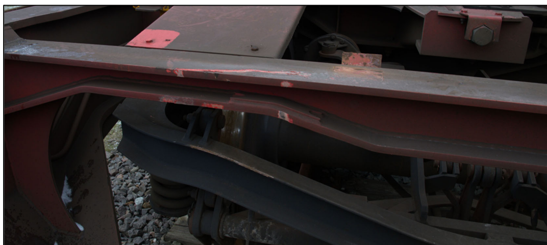
Foto 9: Vognens tværdrager ved bogie. Foto taget umiddelbart efter aflæsning af sættevognstrailer.
