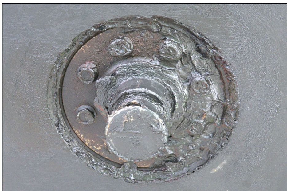
Foto 10: Hovedbolt inden fjernelse af fedt og scanning.
