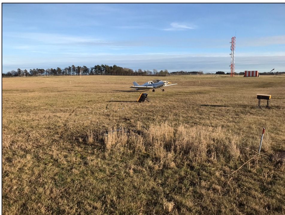
Foto 4. PAPI lampe ramt, revet op og slæbt med
