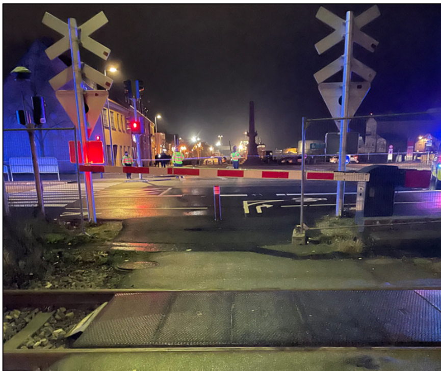
Foto 1. Personens adgangsvej til skinnerne. Billedet er taget umiddelbart efter ulykken.
