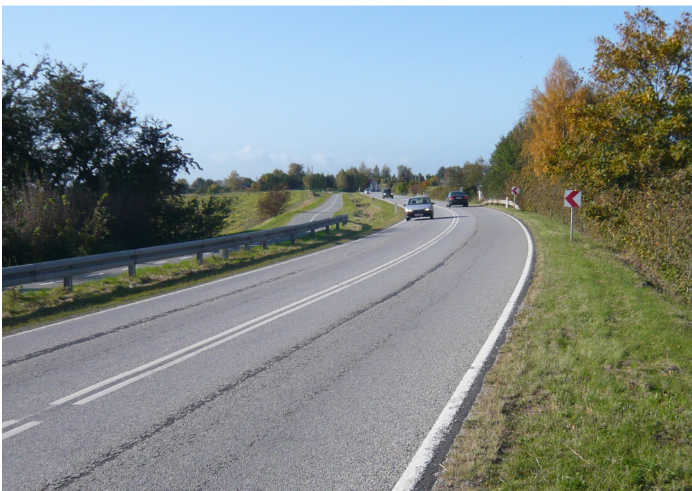
Figur 5. Eksempel på gennemfartsvej i åbent land
