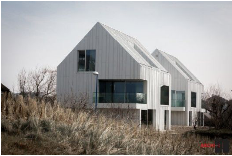
Oostduinkerke Residence BURO II & ARCHI+I
