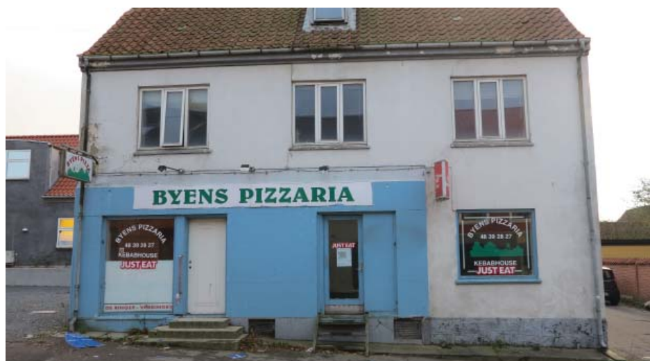
En bygning/butik i Græsted Hovedgade, som kunne trænge til byfornyelse.
