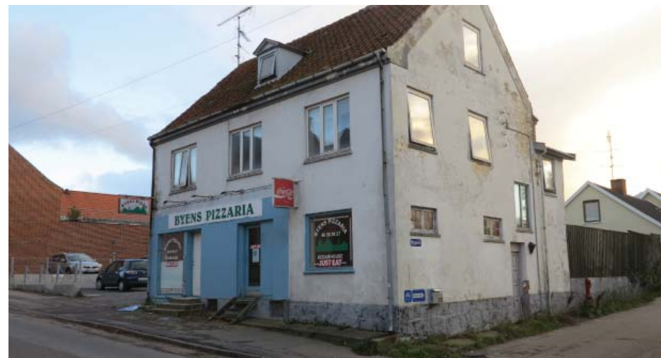
Hus i Græsted Hovedgade - en 'trængende' bygning.
