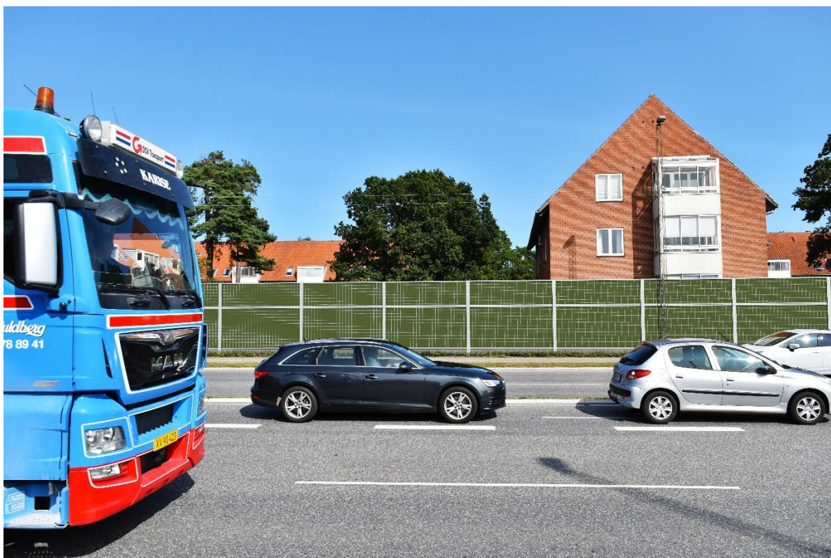
Figur 29: Eksempel på støjskærm ved et etageboligområde. Støjskærmen dæmper støjen på de udendørs opholdsarealer bag skærmen og for boligerne i stueetagen, men ikke for boligerne på 1. og 2. sal.
