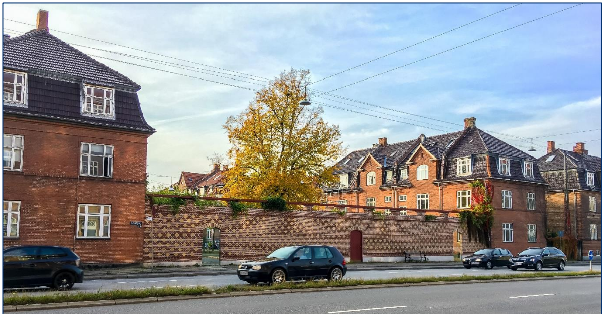
Figur 39. Her har en grundejerforening bygget en støjskærm i åbningen mellem to husrækker. Resultatet er et støjbeskyttet område bag skærmen (Lyngbyvej, København)
