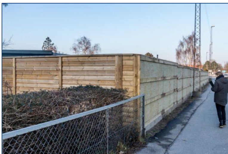
Figur 37. Her har grundejeren bygget sit eget støjhegn og brugt mineraluld på siden mod vejen. Hegnet har formentlig en god støj dæmpende virkning fordi det er tæt, har en god højde og går op i skel vinkelret på vejen. Mineralulden har ingen betydning for hegnets støj dæmpende virkning hos grundejeren.
