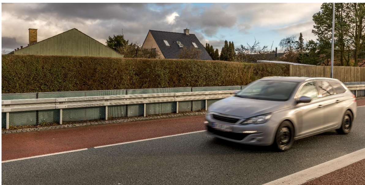
Figur 28. Autoværn, der er udformet som en lav støjskærm. Selvom skærmen er lav, kan der være en støjdempende virkning, fordi den står meget tæt på støjilden (Vejlegårdsvej, Vallensbæk Kommune).
