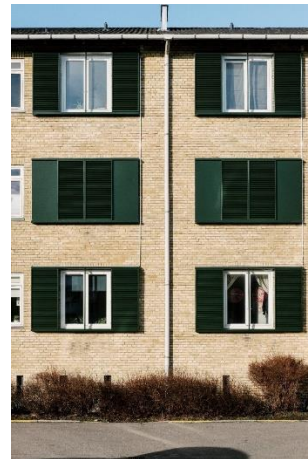
Figur 33. Støjdæpende multifunktionsvindue (billederne til venstre og i midten). Støjen dæmpes på vejen gennem åbningen for neden (udendørs) til åbningen for oven (indendørs). Til højre er vist en lydskodde, som er monteret foran et eksisterende vindue. Den dæmper støjen, men giver også adgang for frisk luft. Den kan desuden mørkelægge et rum, hvis det ønskes.
