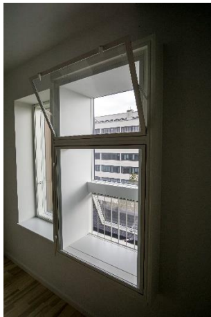
Figur 33. Støjdæpende multifunktionsvindue (billederne til venstre og i midten). Støjen dæmpes på vejen gennem åbningen for neden (udendørs) til åbningen for oven (indendørs). Til højre er vist en lydskodde, som er monteret foran et eksisterende vindue. Den dæmper støjen, men giver også adgang for frisk luft. Den kan desuden mørkelægge et rum, hvis det ønskes.
