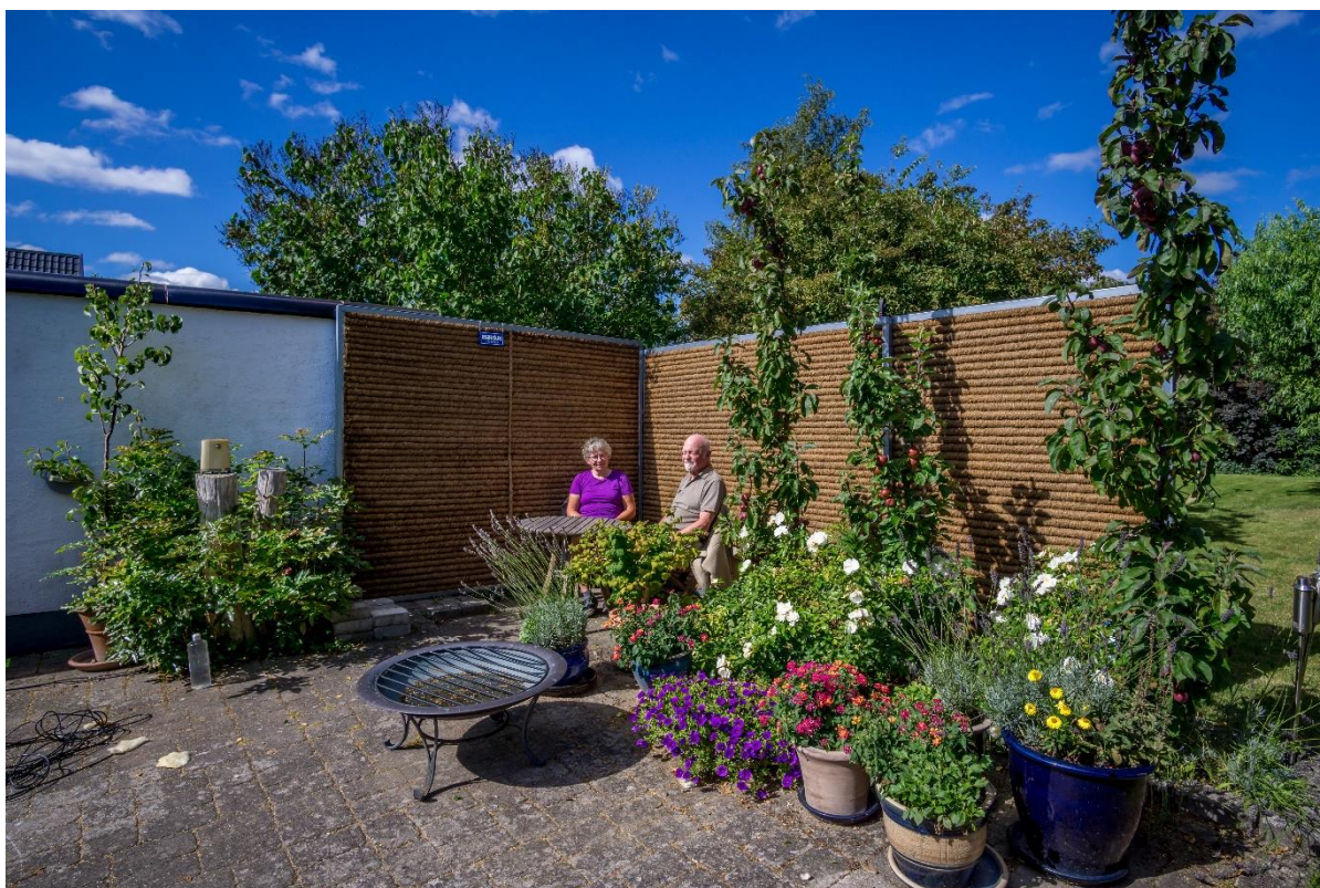
Figur 36. Et støjhegn kan skabe en støjfærmet krog eller terrasse. Den støjdæmpende virkning kan opleves i et mindre område lige op af hegnet (fra en forsøgsopstilling i en have i Glostrup).
