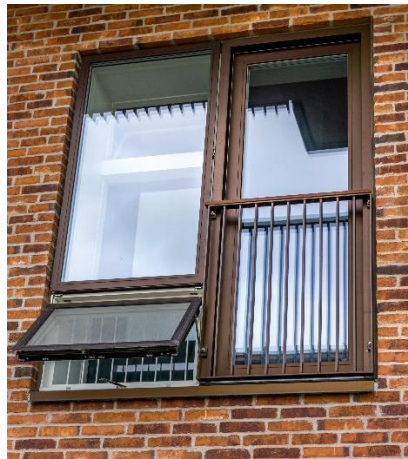
Figur 33. Støjdæpende multifunktionsvindue (billederne til venstre og i midten). Støjen dæmpes på vejen gennem åbningen for neden (udendørs) til åbningen for oven (indendørs). Til højre er vist en lydskodde, som er monteret foran et eksisterende vindue. Den dæmper støjen, men giver også adgang for frisk luft. Den kan desuden mørkelægge et rum, hvis det ønskes.
