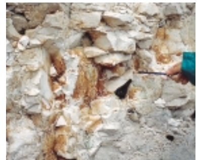
Figur 5. På billede ses sprækkeflade med belægning af jernoxider (rust).
