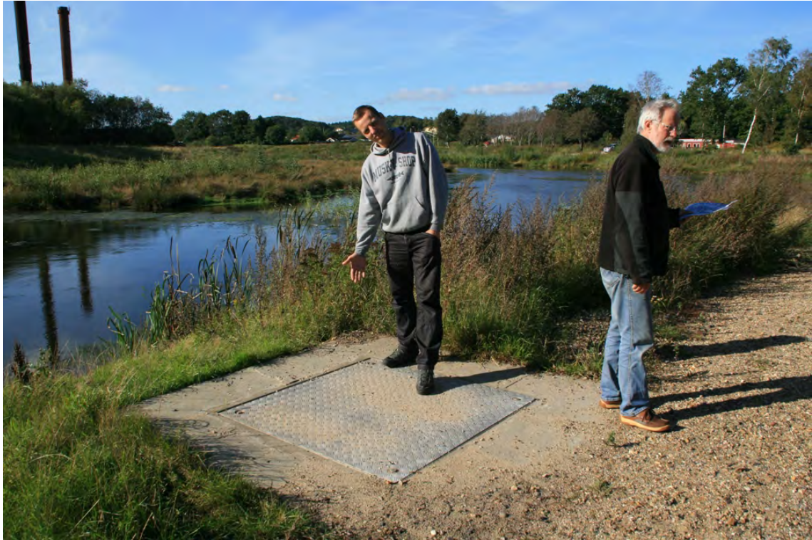
Figur B4-14 Konstruktion (overløb) ved Søholt Bæk nedstrøms motorvej
