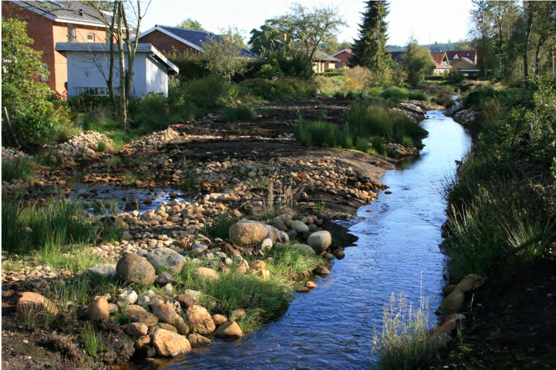
Figur B4-16 Søholt Bæk nedstrøms motorvej efter konstruktion
