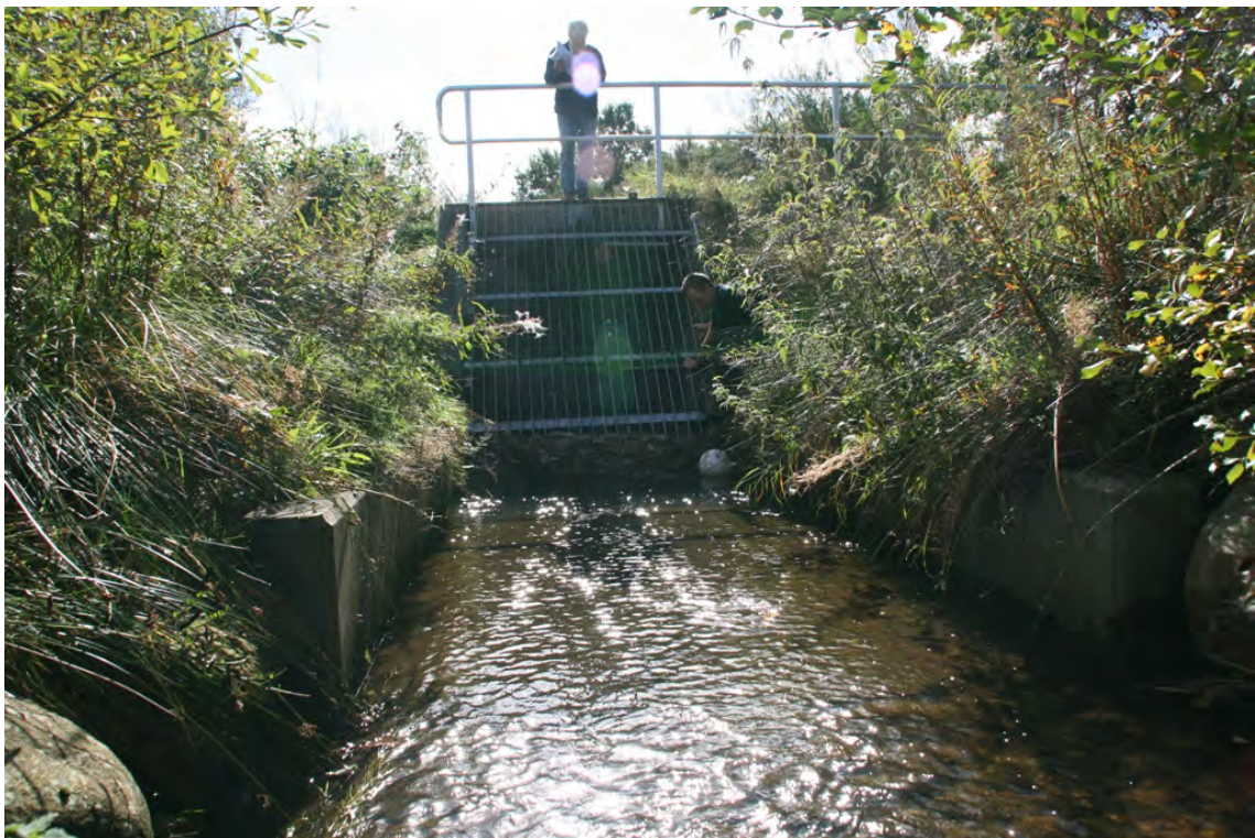
Figur B4-4 Konstruktion ved Kejlstrupgrøft tilløb nedstrøms motorvej set nord fra
