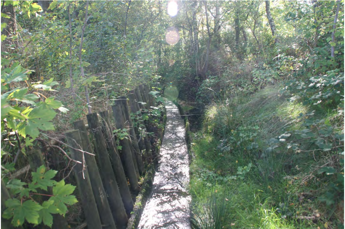
Figur B4-9 Kejlstrupgrøft tilløb opstrøms motorvej umiddelbart efter konstruktion
