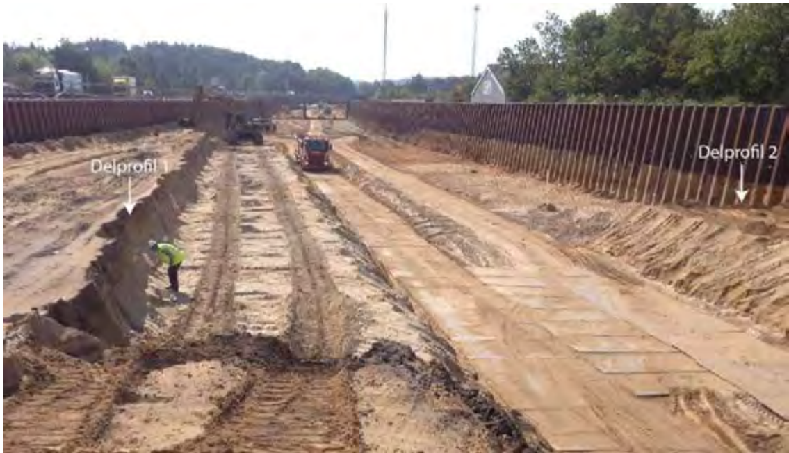
Figur 6. Foto af beliggenheden af profil 1 og 2 ved lokalitet 11. Delprofil 1 er opmålt fra øverste til det mellemste afgravningsniveau, og delprofil 2 er opmålt fra det mellemste til det nederste afgravningsniveau.
