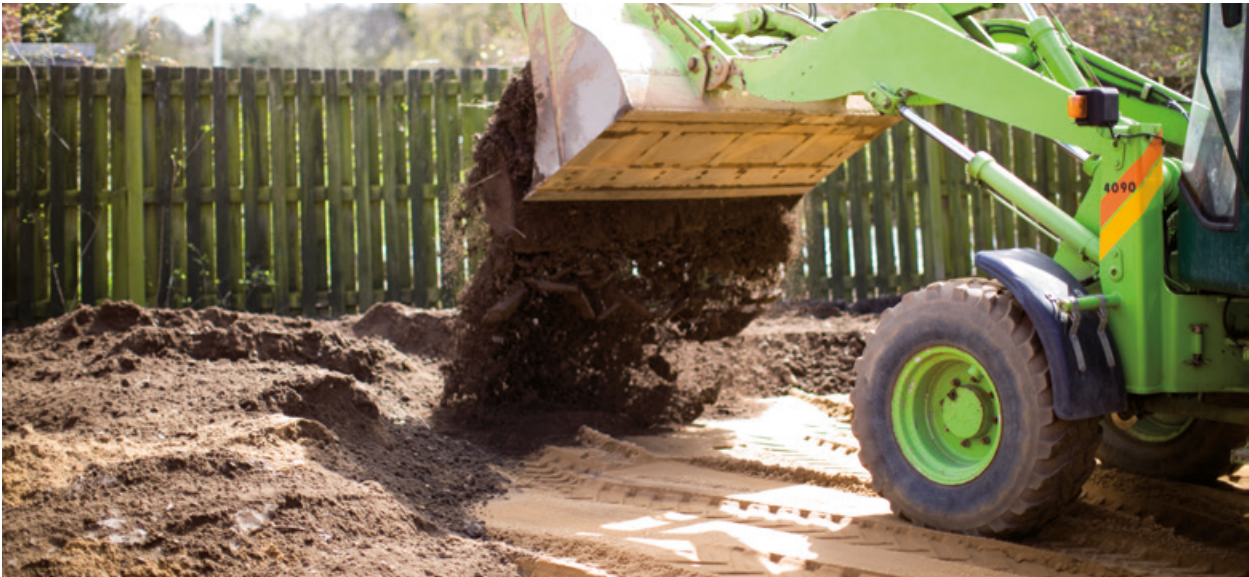
Gravearbejde på forurennet grund
