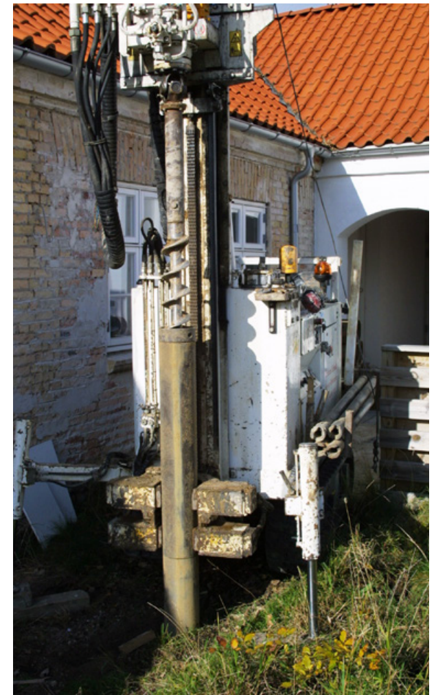
Boring til undersøgelse af forurening
